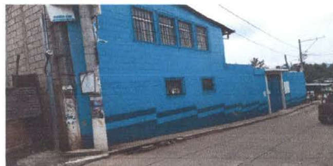
Foto 4: PINTURA EXTERIOR EN PROCESO.
