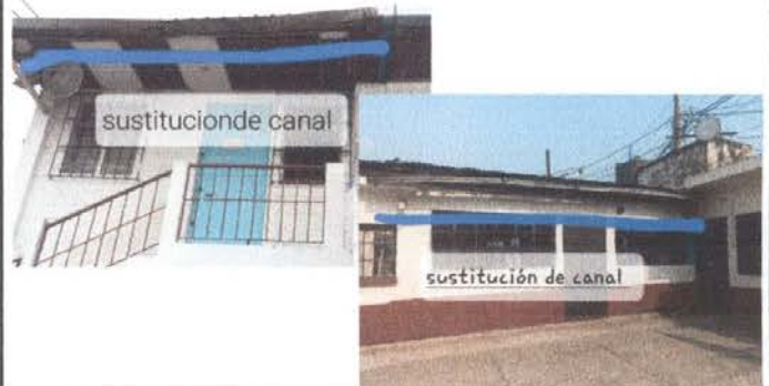
Foto 4: CAMBIO DE CANALES EN PROCESO
