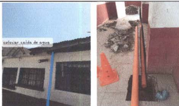
Foto 5: caída de agua en proceso , colocacion de cajas de agua fluvial terminado.
