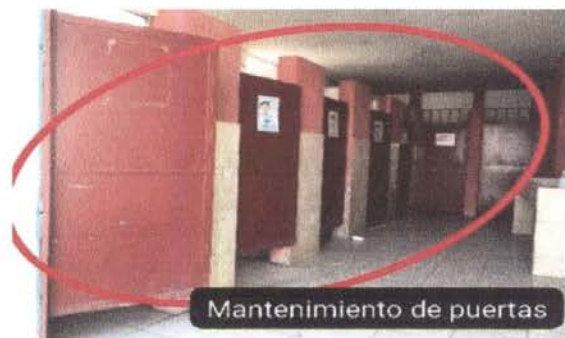
Foto 5: MANTENIMIENTO DE PUERTAS. TERMINADO.
