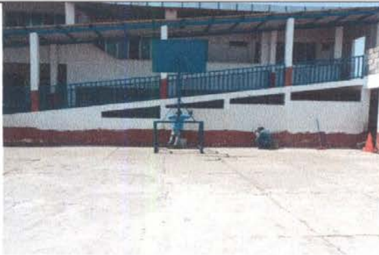
Foto 3: REPELLO DE RAMPA TERMINADO.
