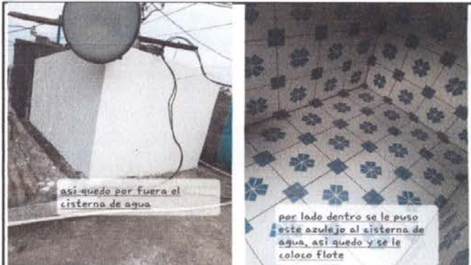
Foto 4: MANTENIMIENTO DE CISTERNA DE AGUA FLUVIAL, TERMINADO.
