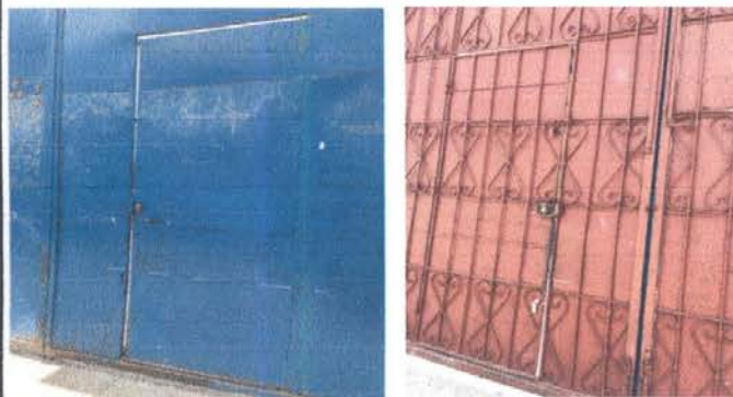
Foto1: remozamiento del portón en proceso.
