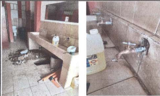
Foto1: DESTAPE DE DRENAJE, CAMBIO DE CHORROS, TERMINADO.
