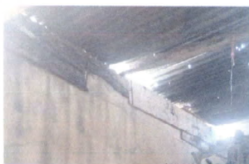
Foto 2: 19.8 Instalación de lámina troquelada aluzinc techado 3.70 mts x 5.00 mts 19.7 Instalación de estructura portante de metal 15.1 Reparación de muro perimetral de block.
