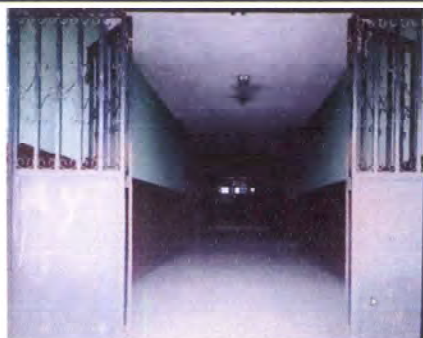
Foto1: Fabricación e instalación de portón de rejas con medidas de 2.50 mts de ancho x 3.00 mts de alto con chapa yale.
