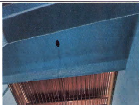
Foto 2: 19.14 Instalación de 4 unidades eléctricas tomacorrientes cableado.
