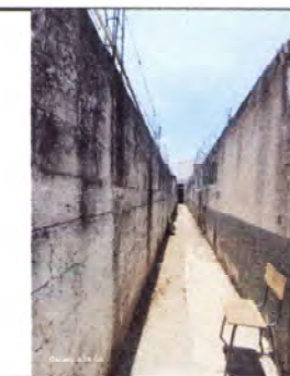
Foto 6: 6.1 Reparación de piso de torta de concreto en pasillo corredor de torta de cemento 34mts de largo x 1 de ancho 14.1 Mantenimiento de 2 reposaderas 14.5 Reparación de tapaderas de 2 cajas.
