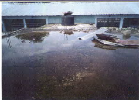
Foto 5: 3.1 Impermeabilizar 610 mts cuadrados de terraza.
