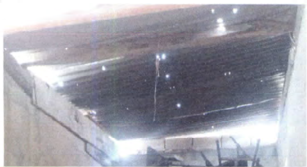
Foto1: 19.8 Instalación de lámina troquelada aluzinc techado 2.30 mts x 5.50 mts 19.7 Instalación de estructura portante de metal 15.1 Reparación de muro perimetral de block.
