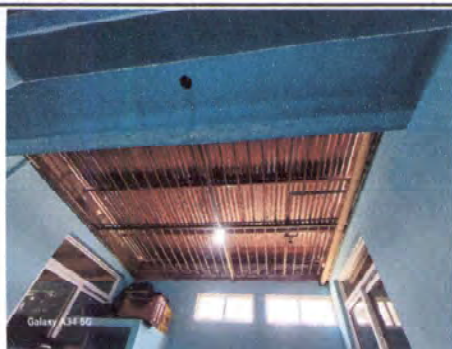
Foto 1: 1.1 Sustitución de 6 láminas troqueladas atornilladas. 4.1 Mantenimiento de reja protectora medida del techo 4 mts x 4 mts total 16 mts más lijado de reja pintado y asercuria 16 mts 21.2 Cernido de block perimetral 5.40 mts 22.1 Reparación de muro perimetro.
