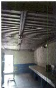
Foto1: Sustitucion de lámina por lamina troquelada aluzinc calibre 26
