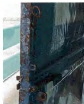
Foto 4: sustitución por chapa.
