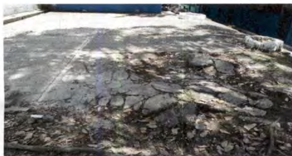
Foto 9: Reparación de planchas de concreto de patio 2
