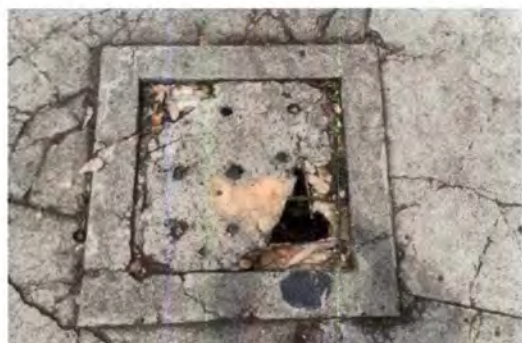
Foto 5: Matenimiento de reposaderas
