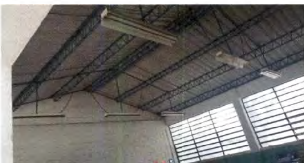
Foto 11: Sustitución de lamparas en aulas.
