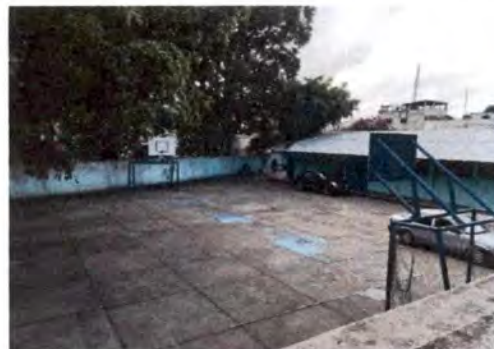
Foto 8: Reparación de planchas de concreto de patio 1
