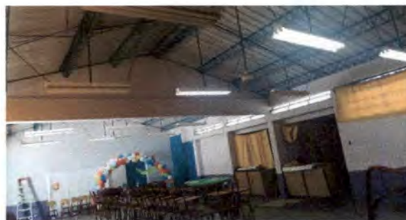
Foto 10: Sustitución de lamparas en Salón Usos multiples.
