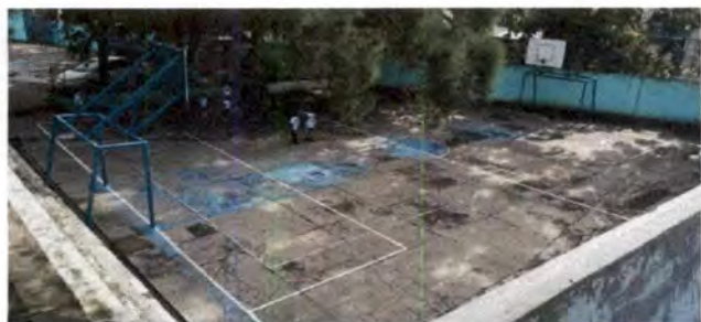
Foto 7: Reparación de planchas de concreto de patio 1
