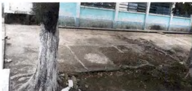
Foto 6: Sustitución de línea de agua potable con tubería PVC de 1/2.
