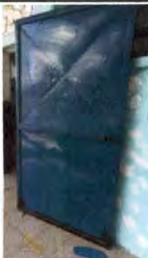
Foto 3: Mantenimiento a puertas lijado, cepillado y aplicación de pintura.
