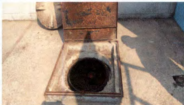
Foto 7: Se realizará la reparación de tapadera de fosa séptica y limpieza de la misma
