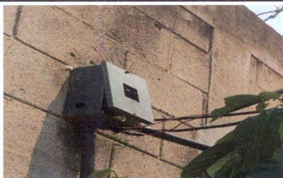
Foto 3: sustitución de tablero de flipones, están ubicados a la interperie y necesitan colocarse modernos para su mejor funcionamiento.
