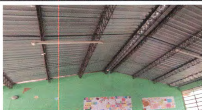
Foto 6: sustitución de timbres y cableado
