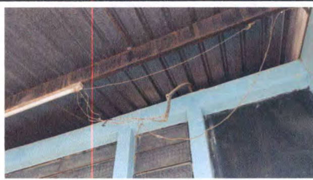
Foto 4: sustitución de lámparas tipo LED en corredores
