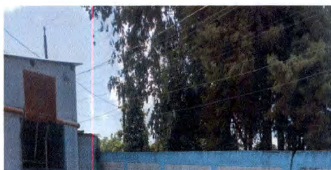
foto 10: Sustitución de pintura a tableros de canchas de basquetboll
