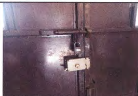
FOTO 16: SUSTITUCIÓN DE CHAPA EN PORTÓN DE INGRESO
