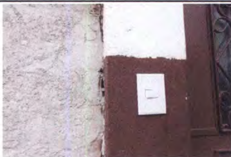
FOTO 13: SUSTITUCIÓN DE INTERRUPTORES
