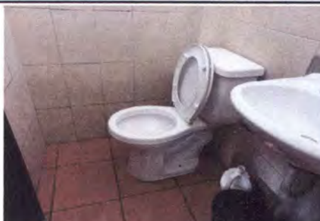
FOTO 14: SUSTITUCIÓN DE INODORO
