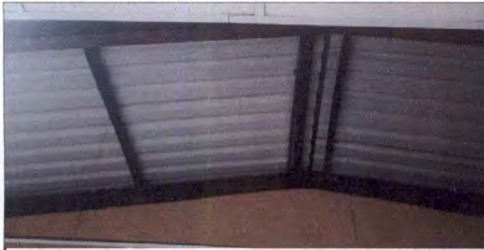
Foto 1: 1.3 SUSTITUCIÓN DE ELEMENTOS DE FIJACIÓN EN CUBIERTA DE LÁMINA PARA REPARACIÓN DE FILTRACIONES, INCLUYE APLICACIÓN DE SIKÁ EN TORNILLOS EN SALON DE USOS MÚLTIPLES
