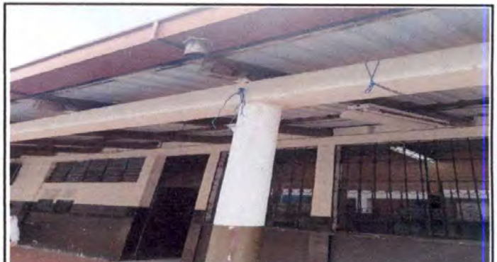
Foto 4: 7.3 INSTALACIÓN DE BAJADAS DE AGUA PLUVIAL
