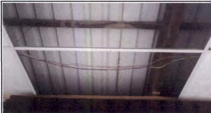
FOTO 13: 17.13 Suministro e instalación entubado y cableado de sonido e iluminación de salón de eventos (incluye tubería para sonido) que están interperie.
