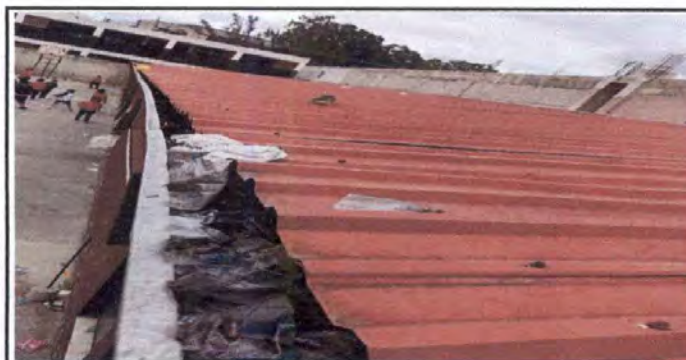
Foto 5: 7.1 LIMPIEZA DE CANALES
