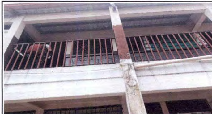
Foto 3: 5.6 SUMINISTRO E INSTALACIÓN DE BALCONES CON MEDIDAS DE 1.21 mt x 2.48 mt. Y 1.21 mt x 1.30 mt.
