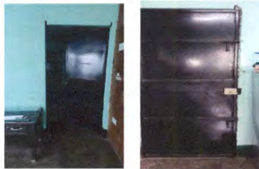
Foto 4: Sustitución de puerta de metal 0.92x2.12 mts. Incluye chapa yale, una costilla para acalajes de 10x20 cms. costilla fundida con cernido.
