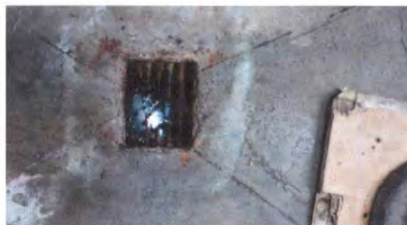
Foto 12: Sustitución 12 metros lineales de tubo pvc de 4", en cocina, incluye fabricación de trampa de grasa de 0.80 x 0.40 mts. con cortina y reposadera.
