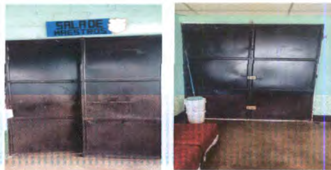
Foto 2: Mantenimiento de portón de 2.04 x 2.45mts., incluye sustitución de 2 chapas yale, desmontaje de portón y ajustar en sala de maestros.
