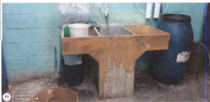
Foto 18: Sustitución de pila de concreto de dos lavaderos e instalación completa: incluye fundición de base de concreto de 2 x 2 mts., conexión a línea de drenaje con tubería pvc e instalación de chorro.
