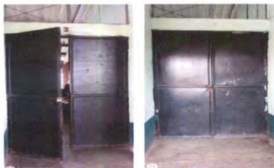
Foto 3: Sustitución de 3 puertas doble hoja de 1.54 x 2.54 mts., con 2 manos de pintura gris fondo y acabado azul con instalación salones: 3, 5 y 6.
