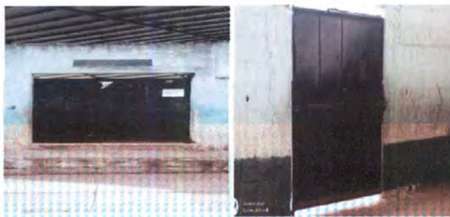
Foto 1: Mantenimiento de portón principal, cepillado, lijado y aplicación de pintura anticorrosivo 8 metros.
