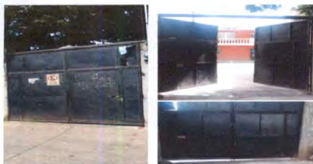
Foto 5: Sustitución de portón de 3.50x3.00 mts. Con puerta, incluye chapa yale No. 16, puerta con ventana, tubo de 2x2, angular, lámina lisa, puntura, tubo de 1 2/4 incluyendo pintura.
