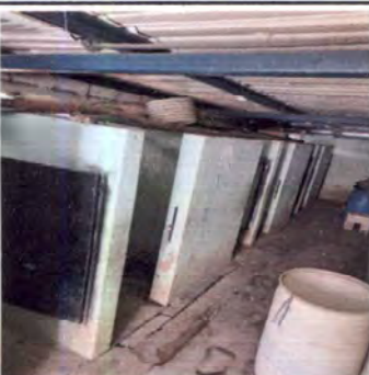
Foto 3: Sanitarios de niñas, sin accesorios y algunos en mal estado. Se propone cambiar los que estan en mal estado y darle mantenimiento a las puertas, colocar piso y azulejo a un metro de alto
