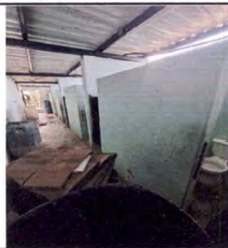
Foto 2: Servicios Sanitarios de Varones, mingitorios de concreto en mal estado, se Propone instalar 6 mingitorios, colocar pizo antideslizante y azulejo a un metro de alto.
