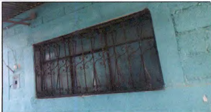
Foto 7:5.1 Mejoramiento a estructura de metal de ventana que incluye lijado, cepillado y aplicación de pintura anticorrosiva con medidas de 2.22 m de ancho por 1.25 metros de alto en aulas.
