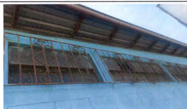
Foto 8: 5.1 Mejoramiento a estructura de metal de ventana que incluye lijado, cepillado y aplicación de pintura anticorrosiva con medidas de 2.30 m de ancho por 1.80 metros de alto en aulas.
