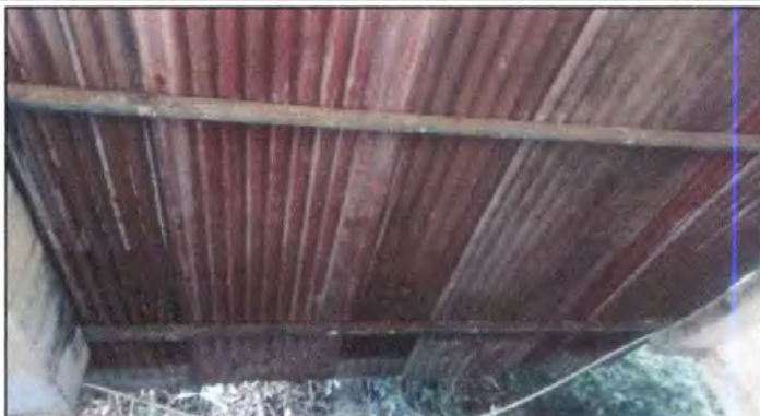
Foto 2: 2.3 Sustitución de estructura de soporte de metal por metal que incluye instalación de estructura metálica elaborada con tubo metálico 2x2 HN Chapa 16
