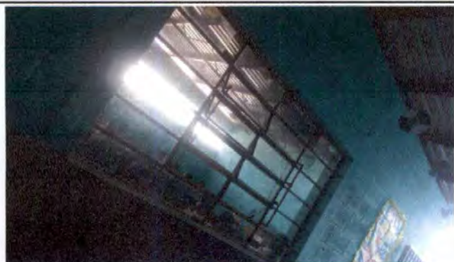
Foto 9: 5.1 Mejoramiento a estructura de metal de ventana que incluye lijado, cepillado y aplicación de pintura anticorrosiva con medidas de 1.12 m de ancho por 1.80 metros de alto en aulas.
