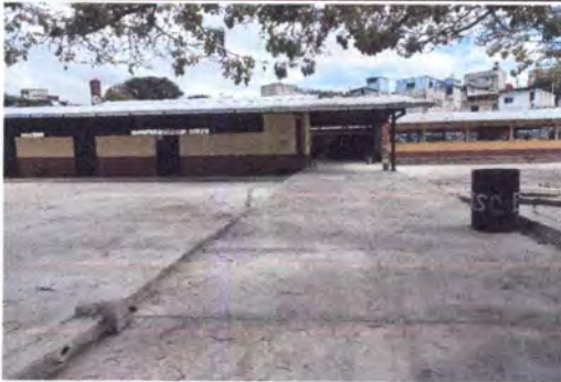
FOTO 1: FUNDICIÓN DE LOSA DE CONCRETO EN PATIO
