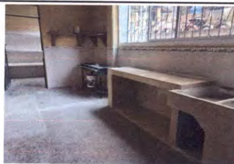
FOTO 10: INSTALACIÓN DE AZULEJO EN COCINA
