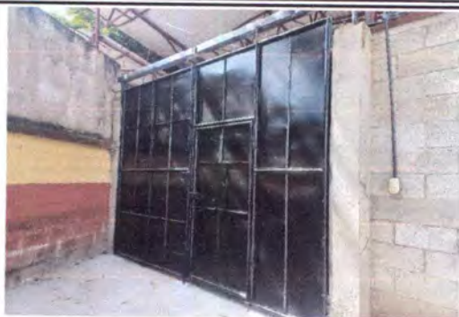
FOTO 7: SUSTITUCIÓN DE PORTÓN DE METAL.
