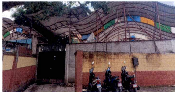
Foto 3: Mejoramiento de perimetro frontal 240 metros2.
