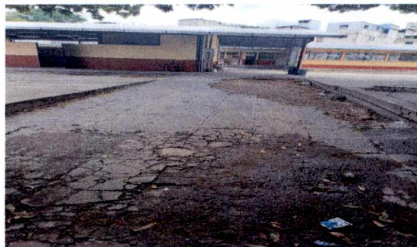
Foto 2: Fundicion de 150 m2 desde la entrada principal hasta las gradass.
