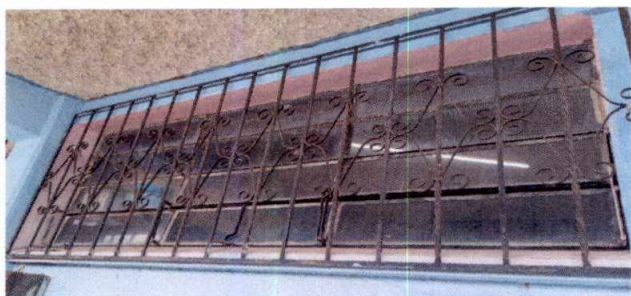
Foto 1: Mejoramiento de ventanería con sustitución de PVC
