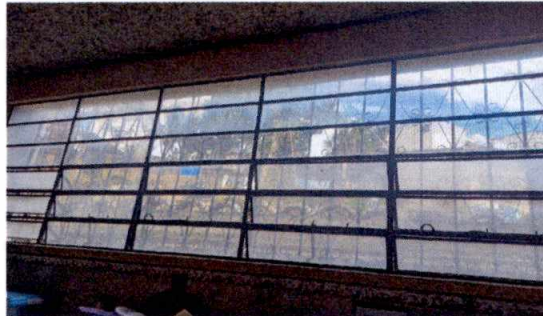
Foto 1: Mejoramiento de ventanería con sustitución de PVC
