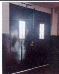
FOTO 16: MANTENIMIENTO A PORTÓN DE METAL
