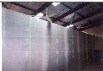
FOTO 17: (TRABAJO EXTRA) SUMINISTRO E INSTALACIÓN DE TABIQUE DE TABLAYESO EN BODEGA
