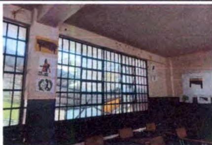
FOTO 15: INSTALACIÓN DE BALCONES EN AULAS Y SERVICIOS SANITARIOS
