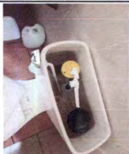
FOTO 13: SUSTITUCIÓN DE ACCESORIOS EN INODOROS
