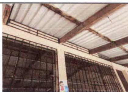
FOTO 18: (TRABAJO EXTRA) SUMINISTRO E INSTALACIÓN DE REJA DE METAL EN AULAS, PARA CUBRIR ESPACIO ENTRE MURO Y CUBIERTA
