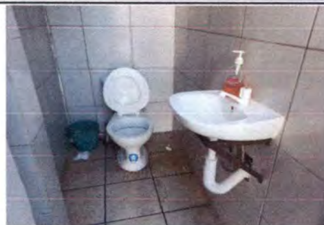
FOTO 14: SUSTITUCIÓN DE INODOROS Y LAVAMANOS E INSTALACIÓN DE AZULEJO
