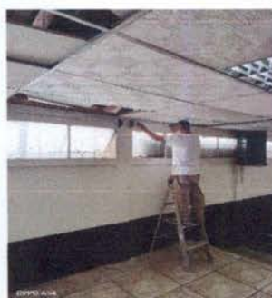
Foto 15: 19. MANO DE OBRA ESPECIALIZADA EN ( ALBAÑILERIA, ELECTRICIDAD HERRERIA Y PLOMERIA)/ 19.11 Instalacion de unidades de luz (Incluyen interruptor, ducto y cable electrico)
