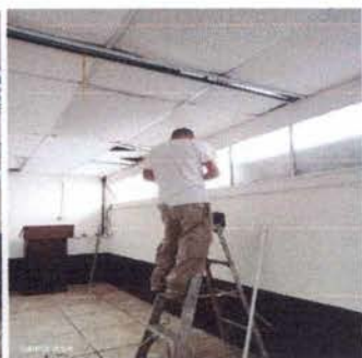
Foto 15: 19. MANO DE OBRA ESPECIALIZADA EN ( ALBAÑILERIA, ELECTRICIDAD HERRERIA Y PLOMERIA)/ 19.11 Instalacion de unidades de luz (Incluyen interruptor, ducto y cable electrico)
