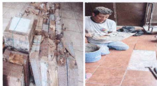
Foto 2: 6. Piso / 6.4 Reparacion de piso ceramico
