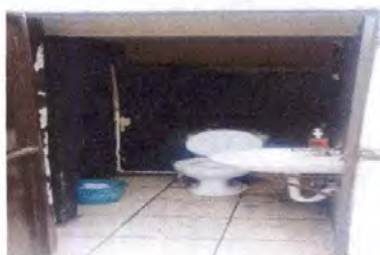
Foto 5:10. SERVICIOS SANITARIOS Y ACCESORIOS / 10. 3 Sustitucion de dos inodoros 10. 4 Sustitucion de dos lavamanos, contrallave, tuvo de abasto.
