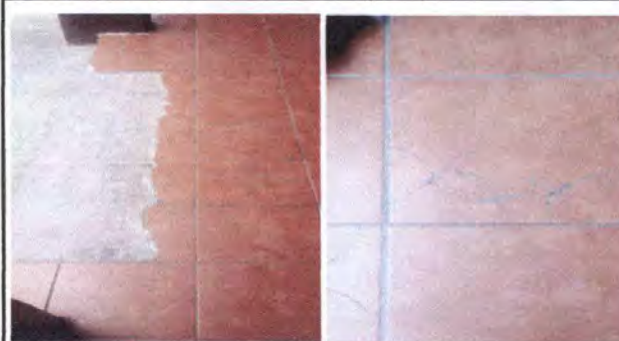
Foto 2: 6. Piso / 6.4 Reparacion de piso ceramico
