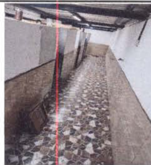
Foto 6: Preparación para la colocación de puertas de sanitarios de niñas.
