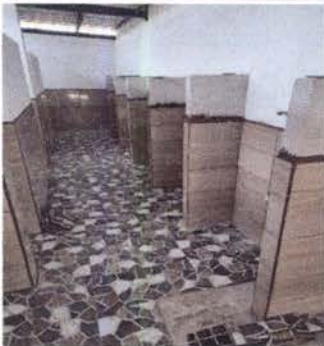
Foto 3: Colocación de tabiques separadores de mingitorios en baño de niños.
