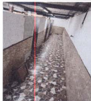
Foto 4: Colocación de piso a un metro de altura en paredes interiores de los baños de niñas.
