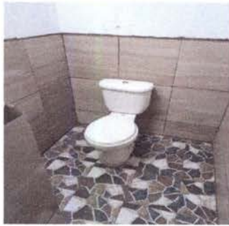
Foto 1: Colocación de sanitarios con sus accesorios en el baño de los niños.
