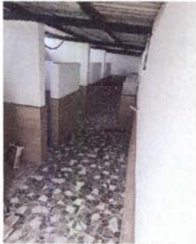
Foto 1: Colocación de piso a un metro de altura en la pared interior de los baños de niños.
