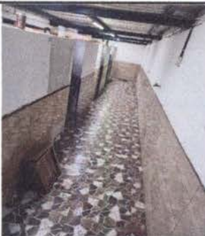
Foto 5: Colocación de piso antideslizante en baño de niñas.
