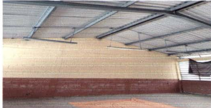
Foto 2: INTERIOR DE SALON 2 LAMINA TROQUELADA ALUZINK CALIBRE 26
