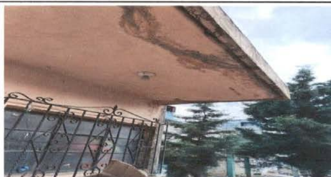
Foto 12: EXTERIOR DE COCINA
