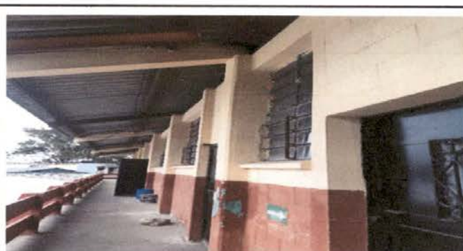
Foto 4: EXTERIOR DE CORREDOR DE LAMINA DE ADVESTO
