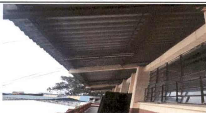
Foto 3: EXTERIOR DE CORREDOR DE LAMINA DE ADVESTO
