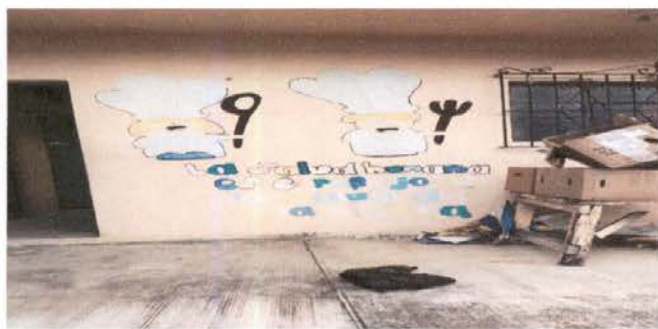
Foto 11: EXTERIOR DE COCINA
