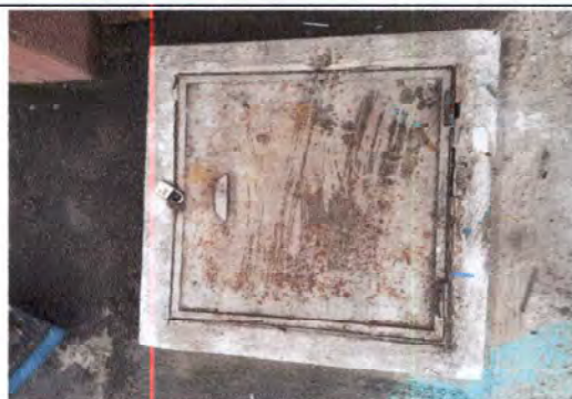
FOTO 8: SUSTITUCIÓN DE TAPADERA DE CISTERNA CON TAPADERA DE METAL ANGULAR DE 1 1/2X3/16 Y LÁMINA DE 3/32 CON REFUERZO EN X.
