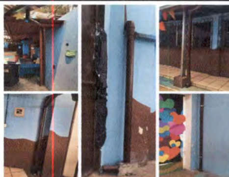
FOTO 4: MEJORAMIENTO DE SISTEMA DE EVACUACIÓN DE AGUAS PLUVIALES CON IMPLEMENTACIÓN DE TUBERÍA SUBTERRÁNEA EN PATIO PARA DESFOGUE HACIA CAJA PLUVIAL EXISTENTE, 46 MTS.
