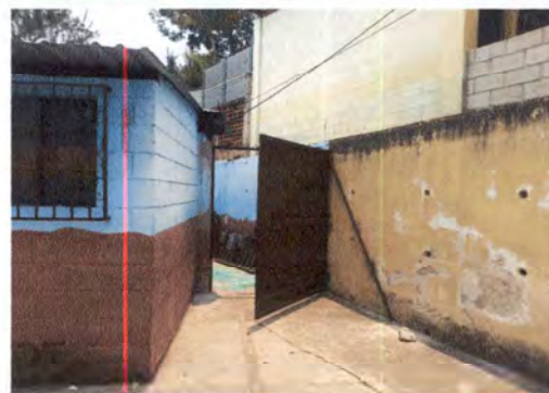
FOTO 2: MEJORAMIENTO DE CERRADO PERIMETRAL A UN COSTADO DE COCINA CON MURO DE 1 X 2.5 MTS CON ACABADOS CORRESPONDIENTES, REINSTALANDO PUERTA LIJADA, CEPILLADA Y
