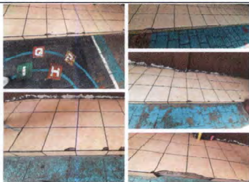
FOTO 7: SUSTITUCIÓN DE PISO CERÁMICO ANTIDESLIZANTE QUEBRADOS Y EN MAL ESTADO EN CORREDOR DE PATIO.
