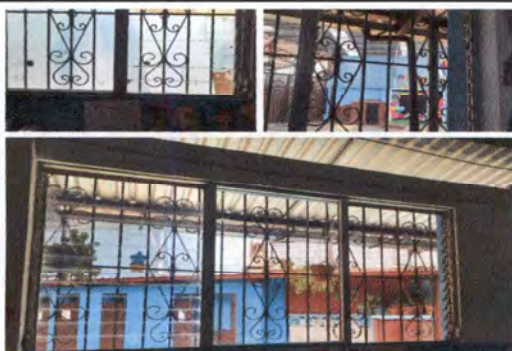
FOTO 5: REPARACIÓN DE VENTANERÍA Y SUSTITUCIÓN POR VENTANAS CORREDIZAS ELABORADAS CON PVC, EN TODO EL MÓDULO DE AULAS
