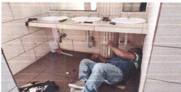
Foto 11: 10.9 Sustitucion de grifos, en area de baños de niños y de niñas de normales a grifos automaticos.
