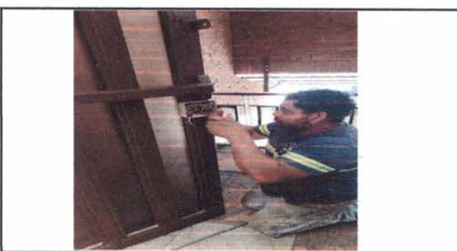
Foto 6: 4.2 Sustitución de chapa, en el portón principal del establecimiento por una chapa eléctrica. Colocando 70 mts de cable para poder abrir desde el área de oficinas.
