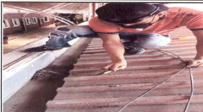
LIMPIEZA DE CANALES Y TECHO
