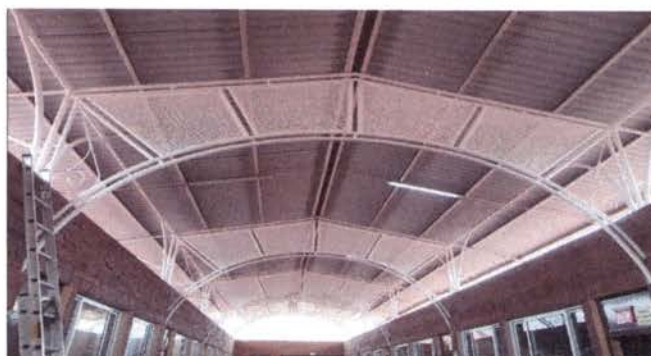
PINTURA DE TECHO INTERIOR
