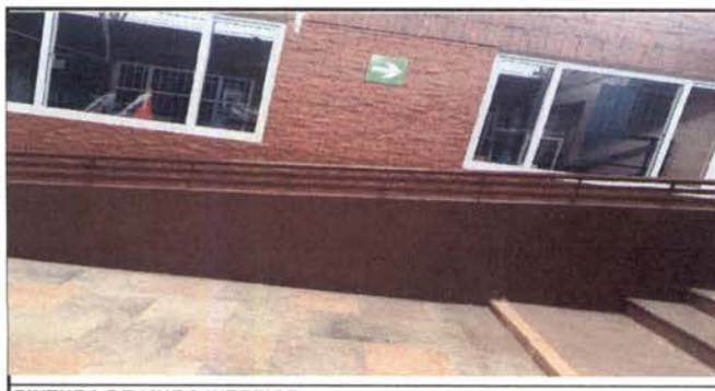
PINTURA DE MURO INTERIOR
