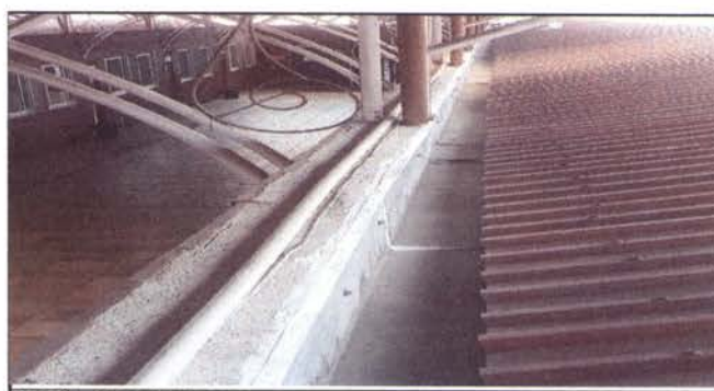
LIMPIEZA DE CANALES
