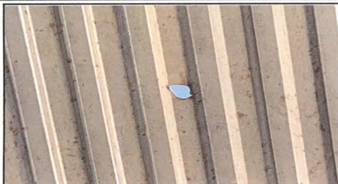
Foto1: 1.1 SUSTITUCIÓN DE LAMINA PLASTICA EN EL CORREDOR
