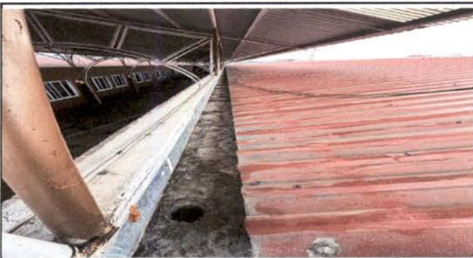
Foto 3: 3.3 SELLADO DE PUNTOS EXISTENTES DE TORNILLOS, JUNTAS Y MUROS VECINDARIOS
