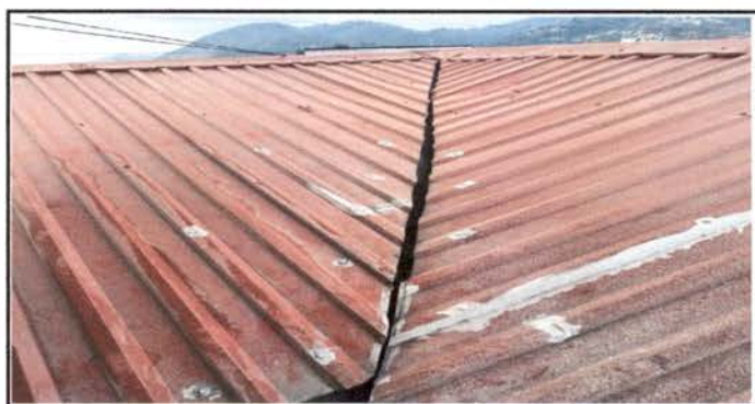
Foto 6: 3.1 IMPERMEABILIZACION DE LOZA DE TECHO EXTERIOR
