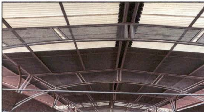
Foto 2: 2.1 MANTENIMIENTO A ESTRUCTURA DE METAL DEL PASILLO
