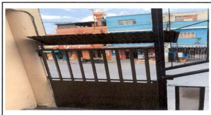
Foto 4: 2.3 FABRICACION DE ESTRUCTURA DE SOPORTE DE METAL
