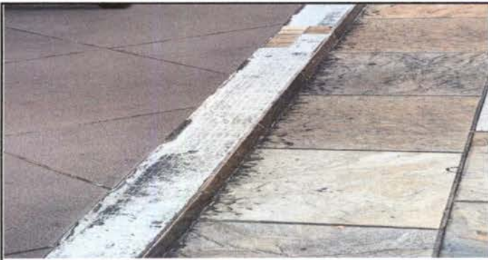
Foto 5: 6.8 SUSTITUCION DE PISO CERAMICO EN PASILLO
