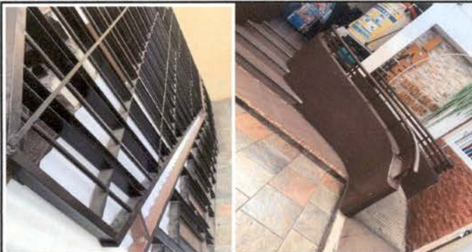
Foto 5: 9.1 APLICACIÓN DE PINTURA EN BARANDALES DE METAL INTERIOR FRENTE A DIRECCION Y EXTERIOR EN ENTRADA PRINCIPAL
