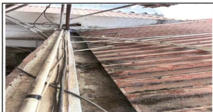
Foto 5: 3.1 IMPERMEABILIZACION DE LOZA DE TECHO EXTERIOR
