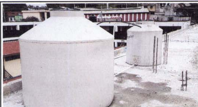
Foto 13: Sustitución de depósito de agua 1700 litros
