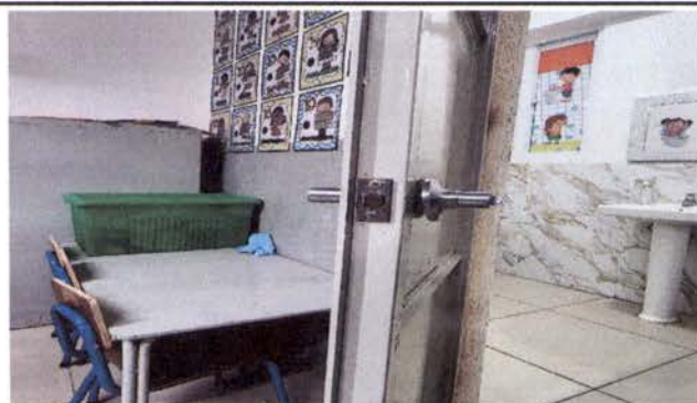
Foto 2: Sustitución de chapa
