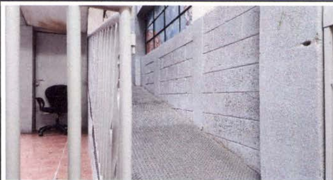
Foto 8: Mantenimiento a barandas de metal
