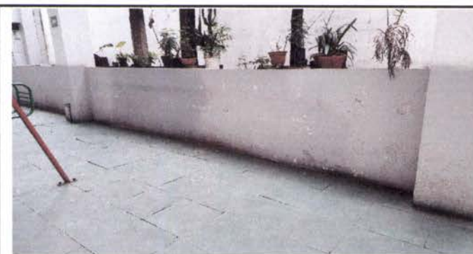
Foto 11: Pintura en muros exteriores e interiores
