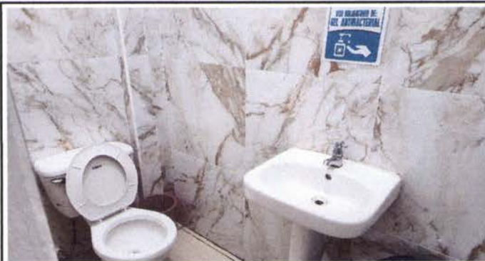
Foto 14: Instación de sanitarios
