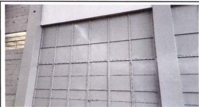
Foto 10: Mantenimiento a portones de metal
