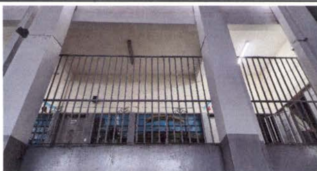
Foto 5: mantenimiento de balcones
