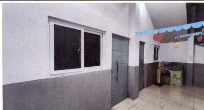
Foto 3: Sustitución de vidrio
