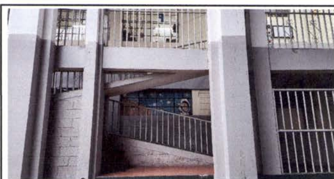
Foto 12: Pintura en muros exteriores e interiores
