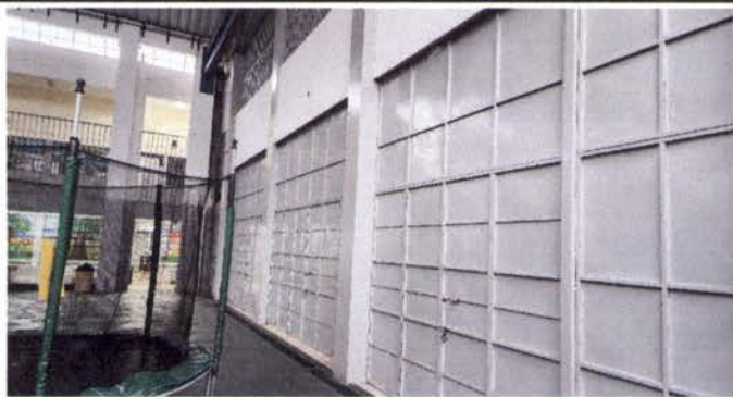
Foto 7: Pintura en muros exteriores e interiores
