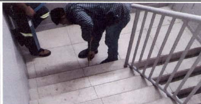
Foto 6: Sustitución de piso cerámico
