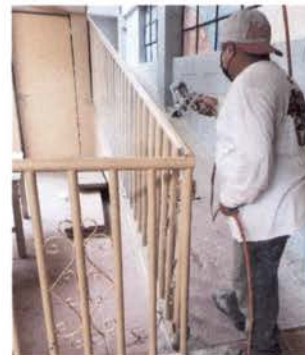
Foto 8: Mantenimiento a barandas de metal
