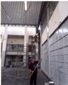
Foto 7: Pintura en muros exteriores e interiores
