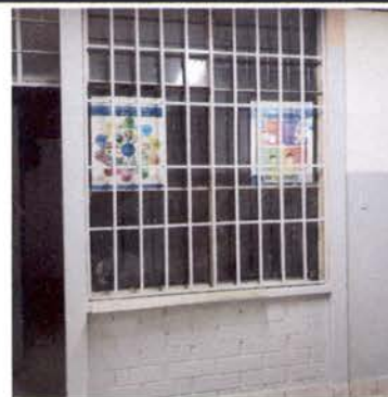
Foto 4: Sustitución de balcones
