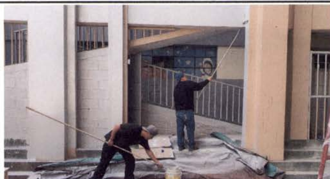
Foto 12: Pintura en muros exteriores e interiores
