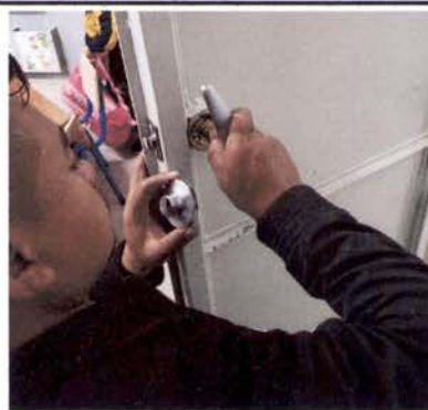
Foto 2: Sustitución de chapa
