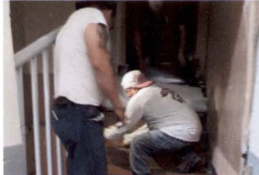
Foto 6: Sustitución de piso cerámico
