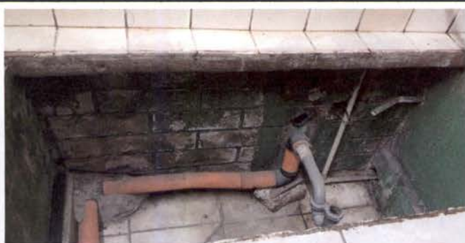
Foto 15: Sustitución de lavatrastos (estado actual corroido) (incluye mezcladora) (PILA) (accesorio)
