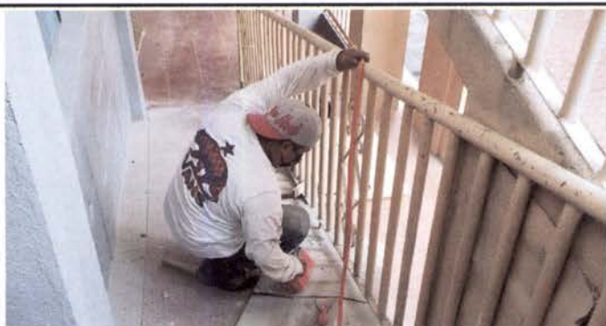
Foto 9: Sustitución de piso cerámico
