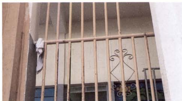
Foto 5: mantenimiento de balcones
