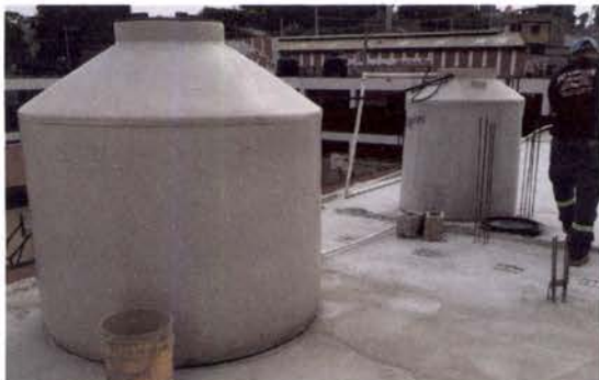
Foto 13: Sustitución de depósito de agua 1700 litros
