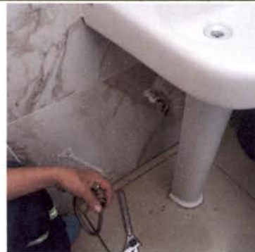
Foto 14: Instación de sanitarios
