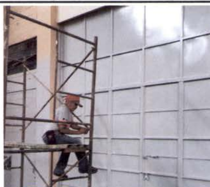
Foto 10: Mantenimiento a portones de metal
