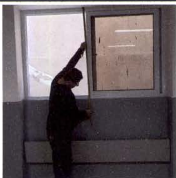
Foto 3: Sustitución de vidrio
