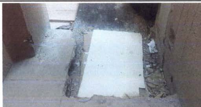
Foto 6: Sustitución de piso cerámico
