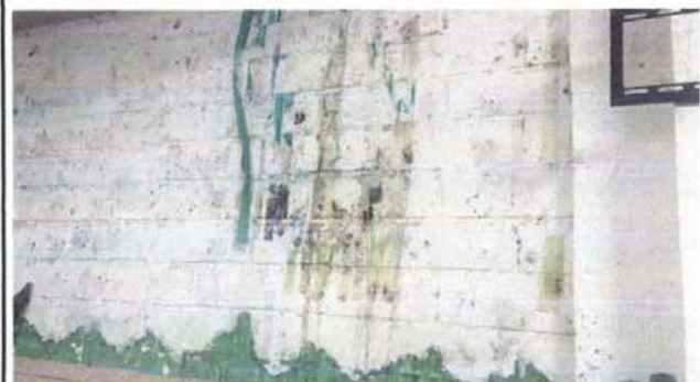
Foto 7: Pintura en muros exteriores e interiores
