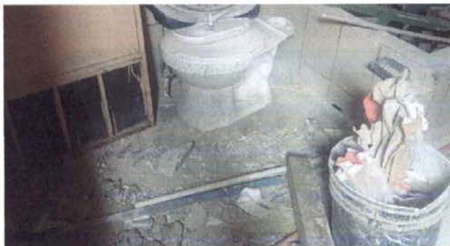
Foto 14: Instalación de sanitarios
