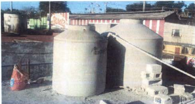
Foto 13: Sustitución de depósito de agua 1700 litros
