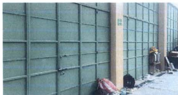
Foto 10: Mantenimiento a portones de metal
