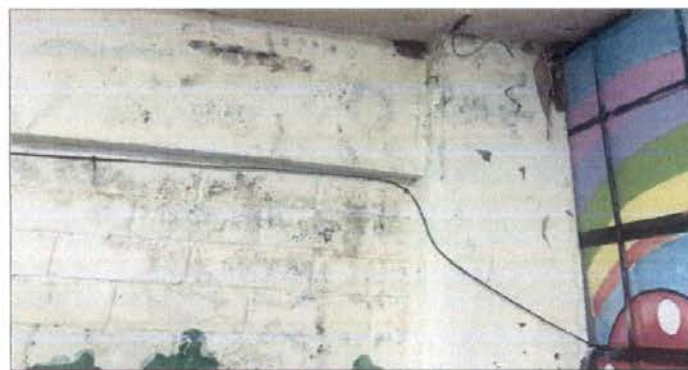
Foto 12: Pintura en muros exteriores e interiores
