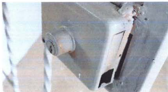
Foto 2: Sustitución de chapa
