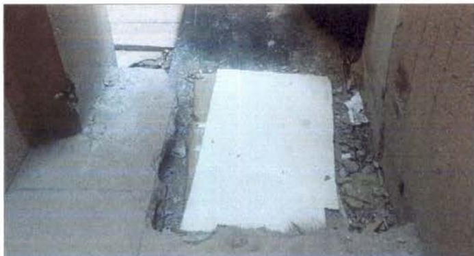
Foto 9: Sustitución de piso cerámico
