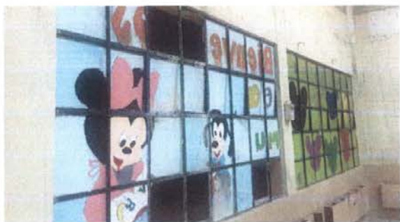
Foto 3: Sustitución de vidrio
