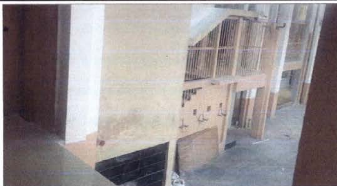
Foto 8: Mantenimiento a barandas de metal
