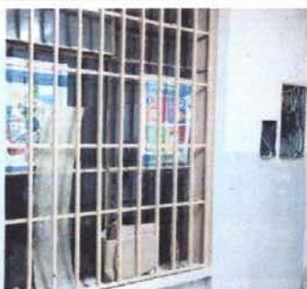
Foto 5: mantenimiento de balcones
