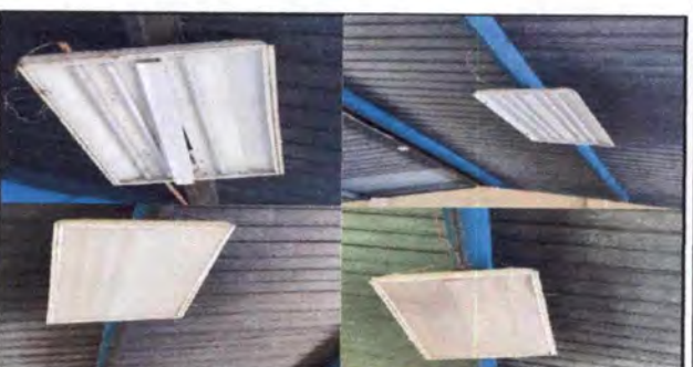
Foto 18: 17.3 SUSTITUCIÓN DE LÁMPARAS POR LÁMPARAS TIPO LED CONTRA POLVO Y HUMEDAD 2X18W (TUBO LED NEVADO) INCLUYE SUSTITUCIÓN DE CABLEADO Y DUCTO ELÉCTRICO CON ACCESORIOS, E INSTALACIÓN DE SUS RESPECTIVOS INTERRUPTORES (EN AULAS)
