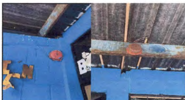
Foto 22: 17.13 INSTALACIÓN DE TIMBRE, INCLUYE TIMBRE Y MATERIALES
