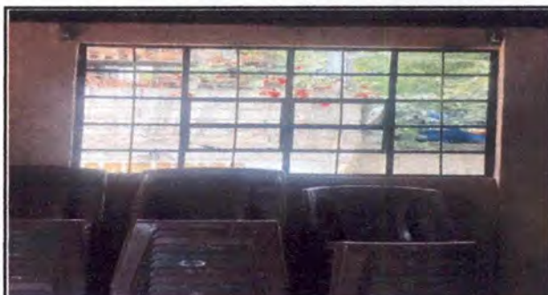
Foto 10: 5.2 SUSTITUCIÓN DE VENTANA POR VENTANA DE PVC CORREDIZA (MEDIDAS: 1.37 MTS. X 1.04 MTS.) EN DIRECCIÓN
