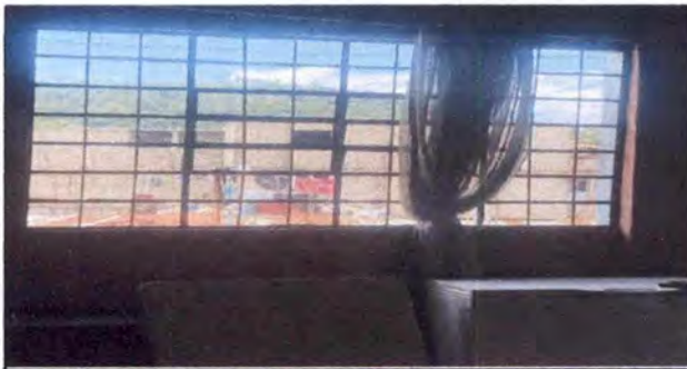
Foto 12: 5.6 INSTALACIÓN DE BALCÓN DE METAL (MEDIDAS: 2.06 MTS. X 1.60 MTS.) EN DIRECCIÓN
