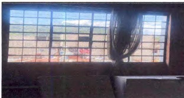
Foto 9: 5.2 SUSTITUCIÓN DE VENTANA POR VENTANA DE PVC CORREDIZA (MEDIDAS: 1.91 MTS. X 1.45 MTS.) EN DIRECCIÓN
