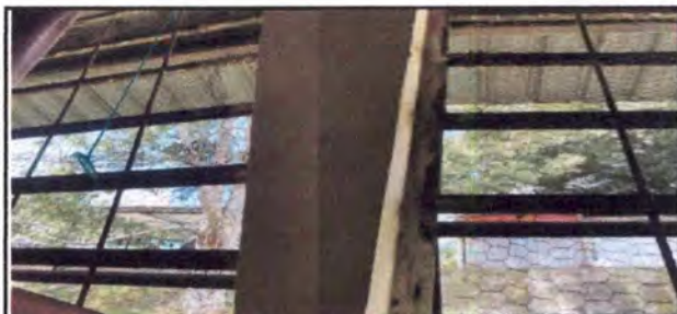
Foto 5: 5.1 MEJORAMIENTO A ESTRUCTURA DE METAL DE VENTANA (POR SEGURIDAD), INCLUYE INSTALACIÓN DE ESTRUCTURAS METÁLICAS ELABORADAS CON: (MALLA CALIBRE 13 CON TUBO TUBO DE 1 PULGADA CHAPA 16, PRENSADO CON PLANO 3/16 POR 1/2 CON MEDIDAS DE 2.30 M. DE ANCHO POR 1.75 M. DE ALTO.
