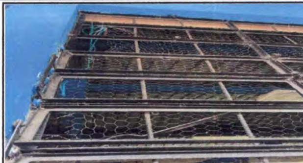
Foto 8: 5.1 MANTENIMIENTO A ESTRUCTURA DE METAL DE VENTANA, INSTALACIÓN DE ESTRUCTURAS METÁLICAS ELABORADAS CON: (MALLA CALIBRE 13 CON TUBO TUBO DE 1 PULGADA CHAPA 16, PRENSADO CON PLANO 3/16 POR 1/2 CON MEDIDAS DE 1.12 M. DE ANCHO POR 1.35 M. DE ALTO, EN AULAS
