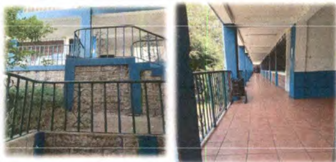
Foto 5: Pintura de barandas y pasamanos
