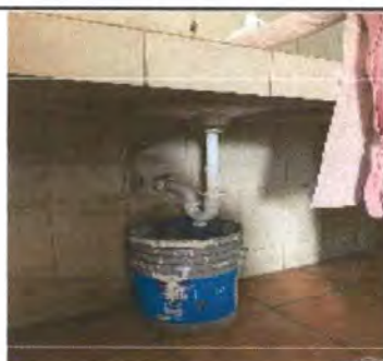
Foto 6: Instalacion de contrallaves para lavamanos
