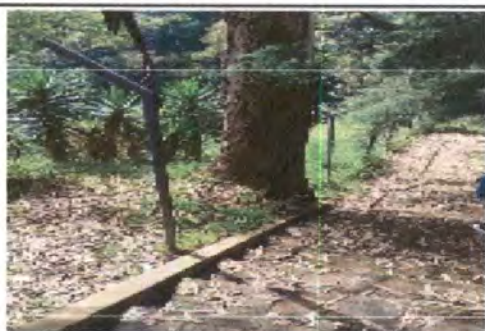
Foto 5: Fabricación de baranda para rampa
