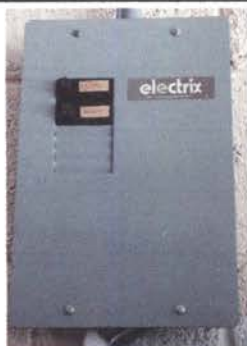
FOTO 9: Sustrucción de tablero de flipones
