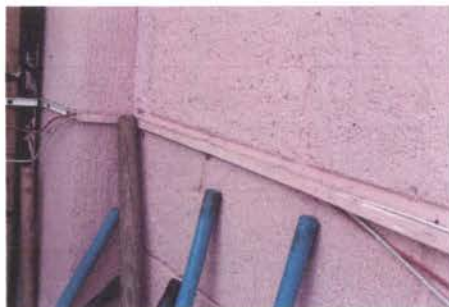
FOTO 11: Sustrucción de ducto eléctrico más accesorios
