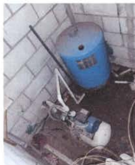
FOTO 2: Sustitución de bomba de agua
