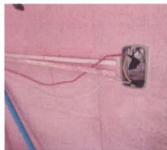
FOTO 10: Reparación de cableado eléctrico
