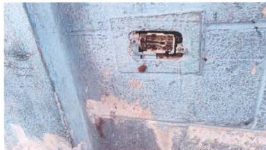
FOTO 8 : Sustrucción de tomacorrientes dobles
