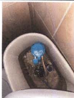
Foto 9: sustitución de accesorios a inodoro
