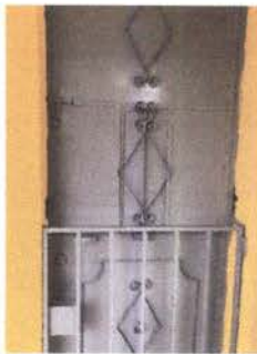
Foto 3: Sustitución de puerta
