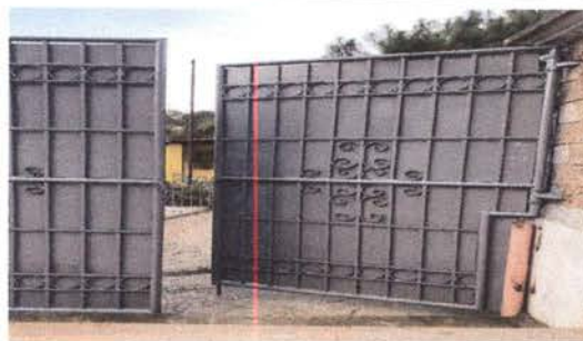
Foto12: Mantenimiento a porton de metal
