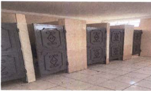
Foto 1: Mantenimiento a la estructura de las puertas
