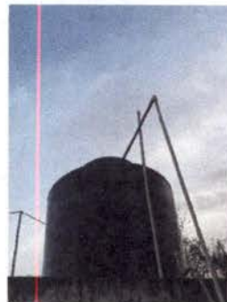
Foto 14: Sustitución de tinaco
