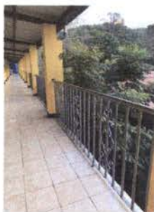
Foto 11: Mantenimiento a barandas de metal
