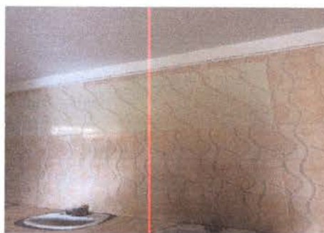
Foto 10: Sustitución de azulejos
