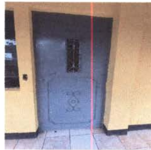
Foto 2: Sustitución de chapa
