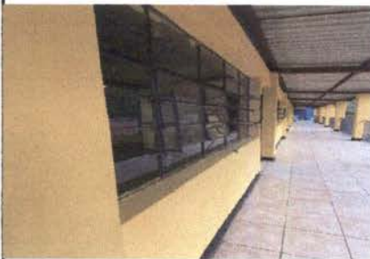
Foto 5: Sustitución de estructura de metal de ventanas
