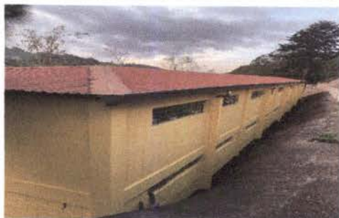
Foto 7: Pintura en muros interiores y exteriores
