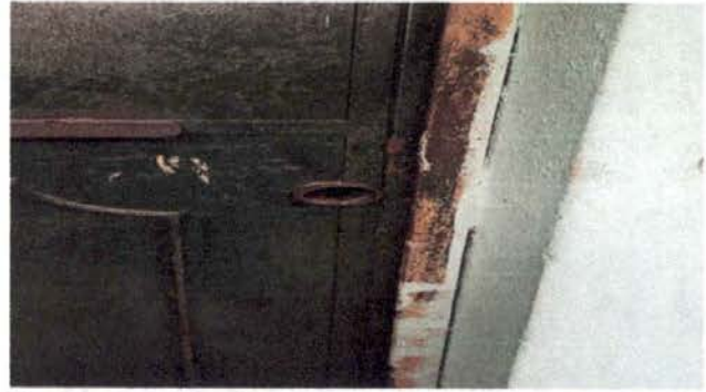
Foto 2: Sustitución de chapa
