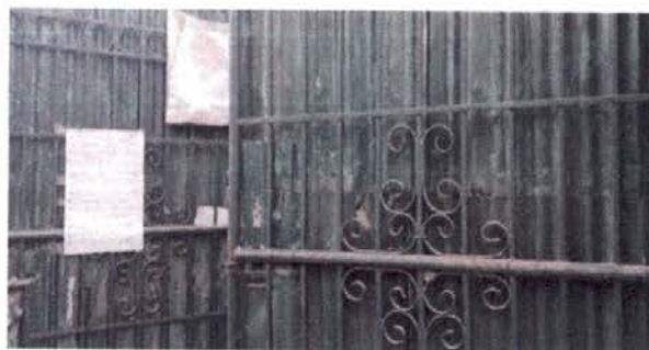
Foto 12: Mantenimiento a portón de metal
