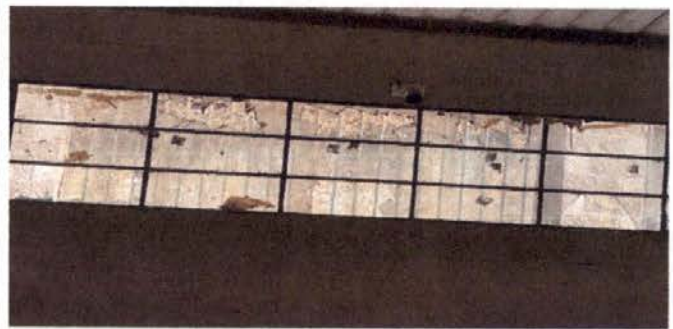
Foto 6: Sustitución de vidrios
