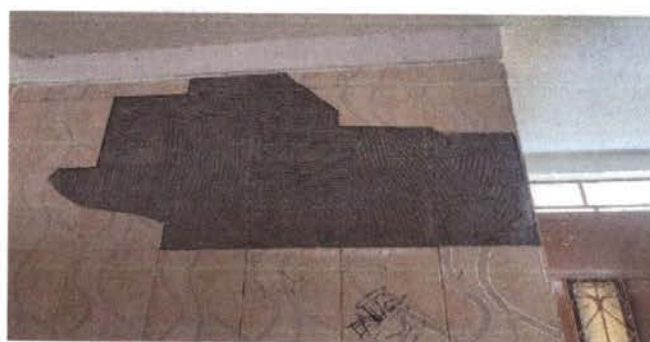
Foto 10: Sustitución de Azulejos
