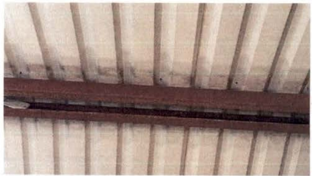
Foto 4: Sustitución de capote de lámina para lámina troquelada.
