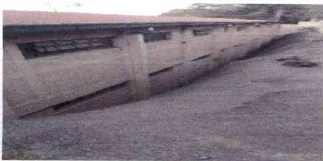
Foto 7: Pintura en muros interiores y exteriores
