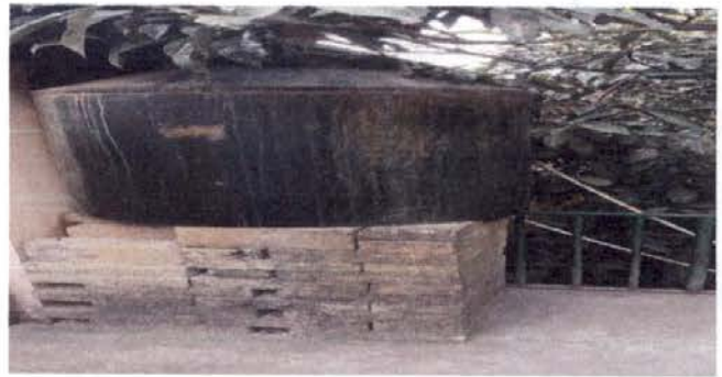
Foto 14: Sustitución de tinaco
