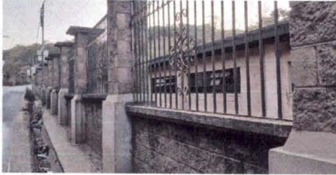
Foto 13: Mantenimiento a balcones de metal
