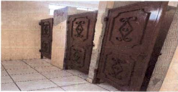
Foto 1: Mantenimiento a la estructura de la puerta
