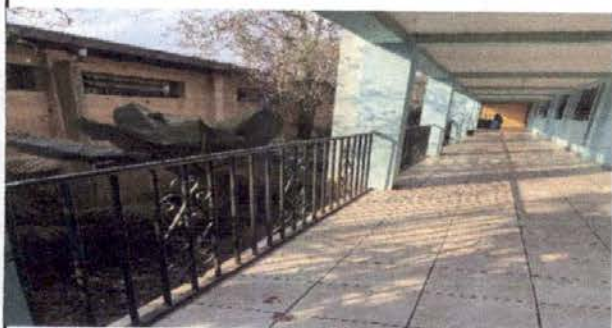
Foto 11: mantenimiento a barandas de metal
