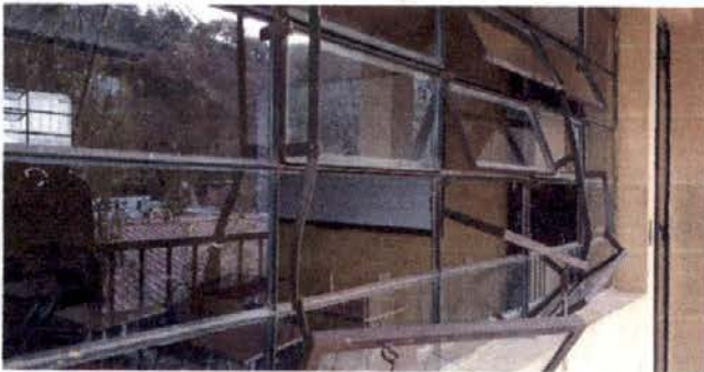
Foto 5: Sustitución de estructura de metal de ventanas
