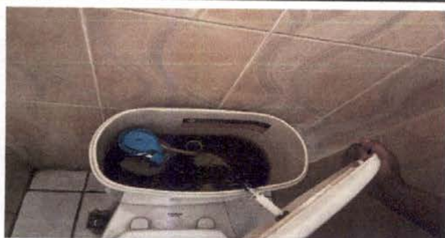
Foto 9: Sustitución de accesorios a inodoro
