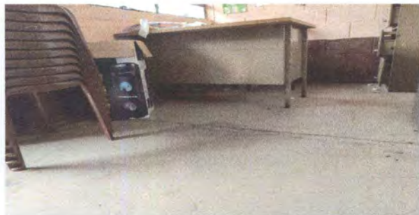
Foto . 1 Sustitución de piso ceramico
