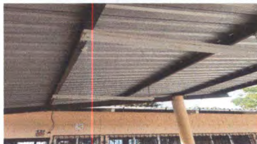
foto. 2 sustrucción de cableado eléctrico + accesorios
