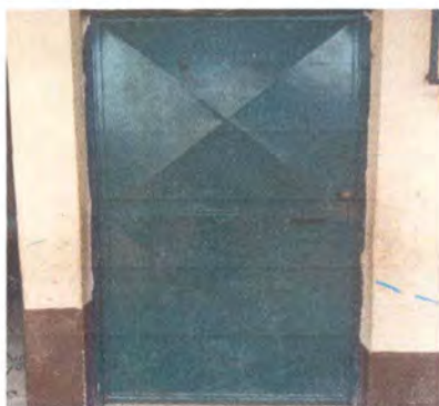
foto.3. mantenimiento a estructura de puertas de metal
