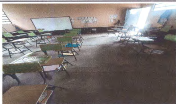
foto. 3 sustitucion de piso ceramico
