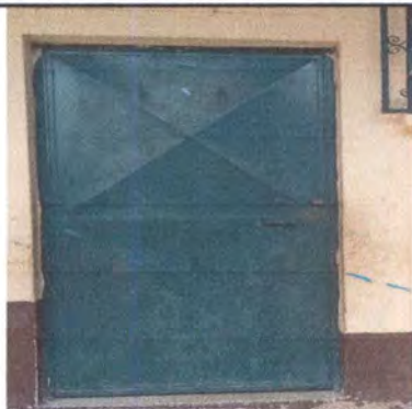
foto. 1 mantenimiento a estructura de puertas de metal
