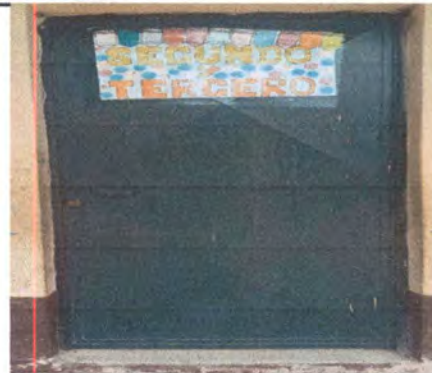
foto. 2 . Mantenimiento a estructura de puertas de metal
