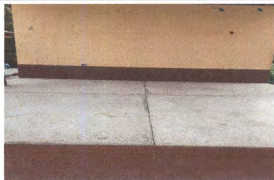
foto. 5 sustitucion de piso ceramico
