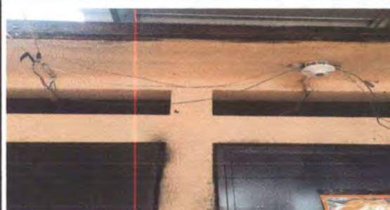
foto. 4 sustrucción de cableado eléctrico + accesorios
