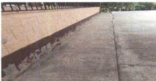
foto. 1 pintura en muros exteriores y interiores
