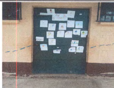
foto.4. mantenimiento a estructura de puertas de metal
