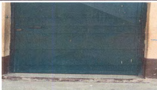
foto. 5. mantenimiento a estructura de puertas de metal
