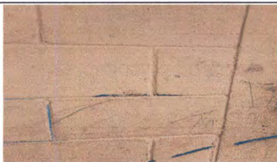
foto. 3 pintura en muros exteriores y interiores
