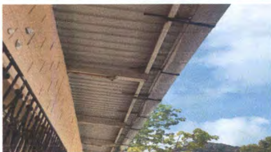
foto. 1 sustrucción de cableado eléctrico + accesorios
