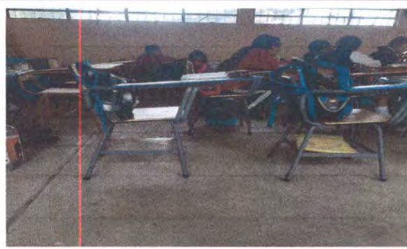
foto. 6 sustitucion de piso ceramico
