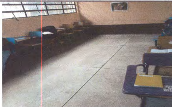
foto. 4 sustitucion de piso ceramico
