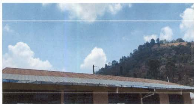
Foto 7: cambio de lámina por lámina troquelada de calibre 26
