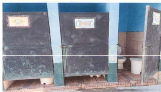
Foto 6: sanitarios, se debe arreglar ya que están conectados a una misma fosa y al echar agua en uno, se sale en el otro
