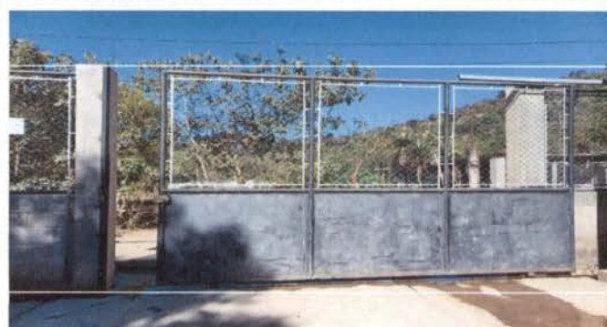
Foto 8: Reparación de portón
