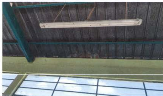
Foto 2: lámina oxidada por el agua que se cuele
