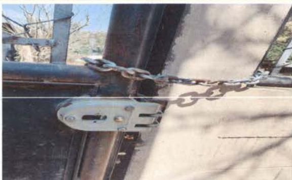
Foto 5: las chapas de los portones están descompuestas, por lo que se debe cerrar con candado y cadena
