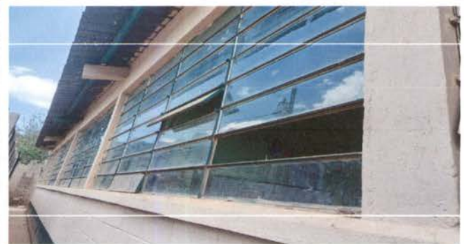
Foto 9: Cambio de vidrios
