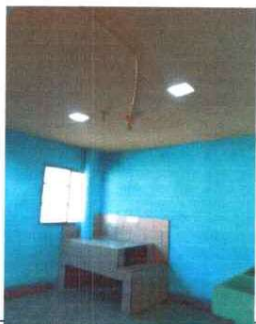
Foto 1: Instalación de estufa rural ( completa ) incluye chimenea y plancha de metal
