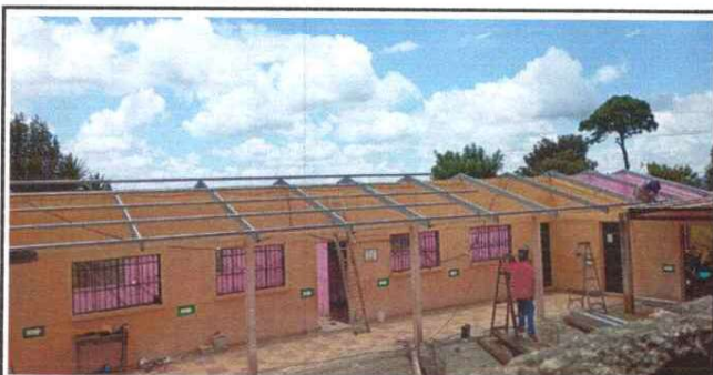
Foto 5: Instalación de estructura de soporte de metal.
