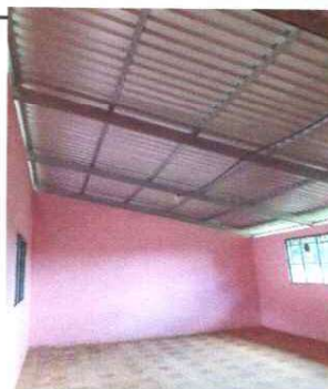
Foto 4 : Instalación de lámina troquelada.
