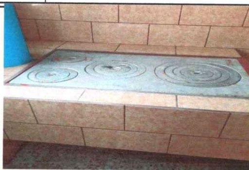
Foto 2 : Instalacion de plancha.
