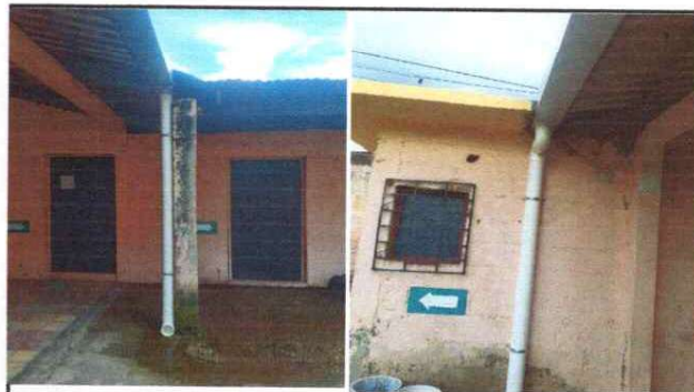
Foto 8: Instalación de lámina troquelada Aluzinc calibre 26.
