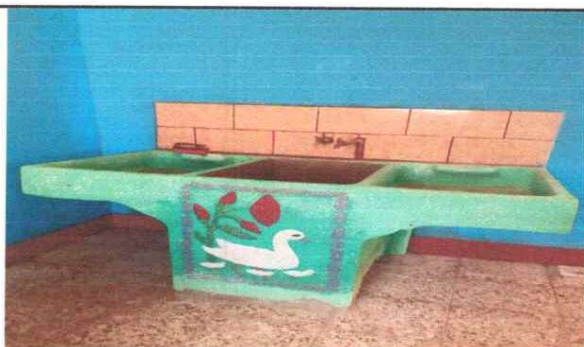
Foto 3 : Instalación de pila.
