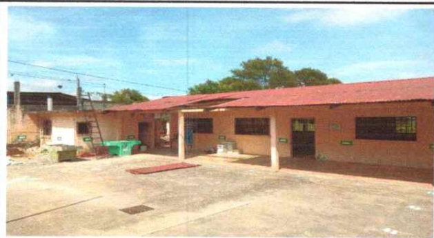
Foto 1: inicio de Desinstalación de techo
