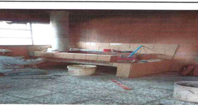
Foto 11 : Se encuentra en proceso la instalación de azulejo en estufa rural.
