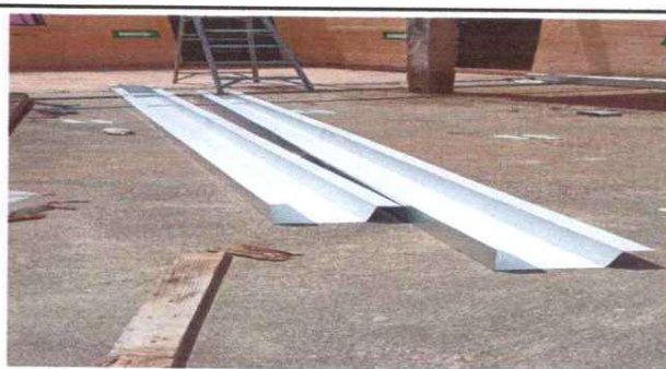
Foto 6 : Proceso de instalación de canales.
