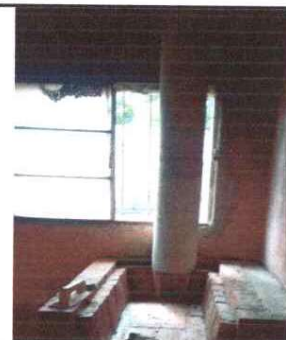
Foto: 12: Instalación de tubo para chimenea.
