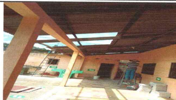
Foto 2: Proceso de desinstalación de techo.
