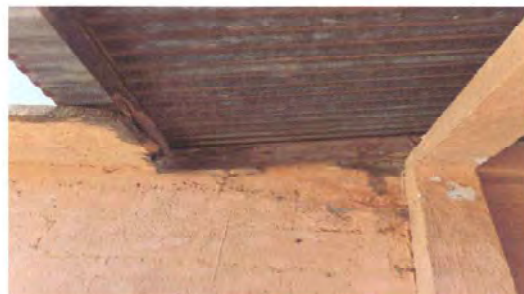
Foto 2: Complementación de canales de metal.
