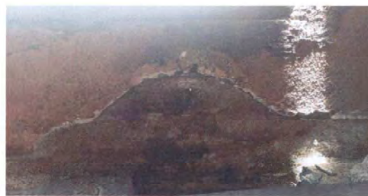
Foto 6: Instalación de azulejo en estufa rural.
