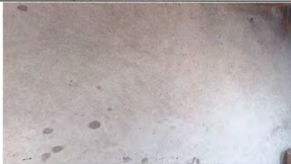
Foto 2: Sustrucción de piso de torta de concreto
