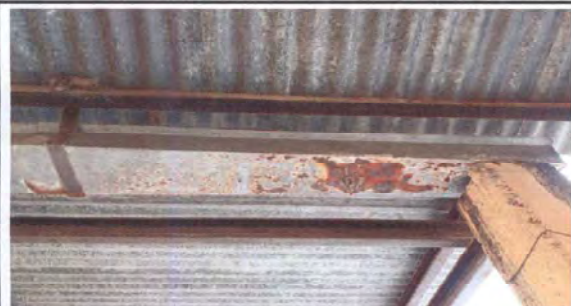
Foto 1: Los canales se encuentran en muy mal estado y ya no cumplen con su función.
