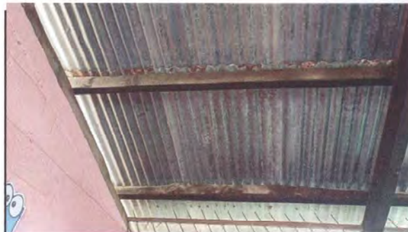
Foto 4 : Sustrucción de lámina, por lámina troquelada aluzinc calibre 26
