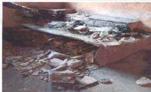
Foto 1: Sustrucción de estufa rural ( completa ) incluye chimenea y plancha de metal
