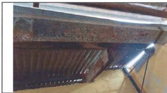
Foto 6: Sustrucción de canal de metal
