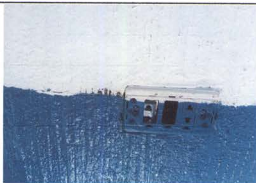
Foto 3: sustitucion de tomacorrientes de los pasillos
