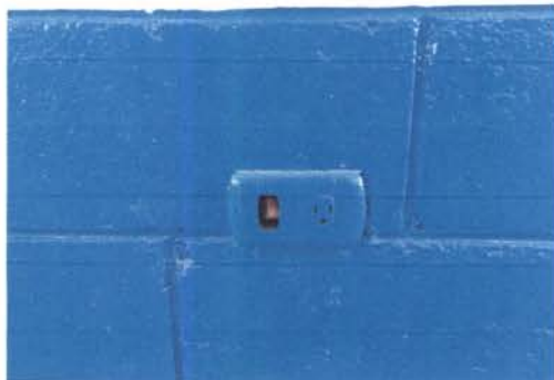
Foto1: Sustitucion de tomacorrientes
