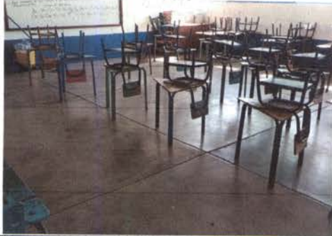
Foto1: Sustitucion piso de torta de concreto por piso cerámico antideslizante en aula 1.
