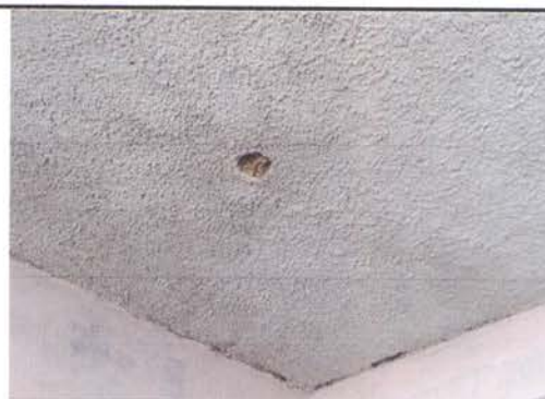
Foto 6: sustitupcion de lampara led
