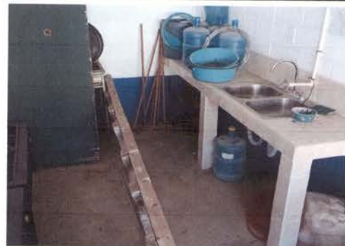
Foto 4: sustitucion de piso de torta por piso cerámico antideslizante en cocina
