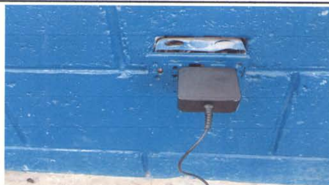
Foto 2: sustitucion de tomacorrientes
