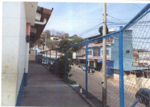
Foto1: colocacion de reison en las áreas perimetrales de malla para seguridad.
