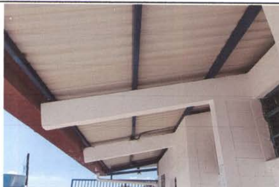
Foto 4: colocacion de laparas led
