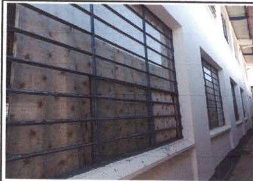
Foto 6: Colocacion de balcones y cedazo de aulas
