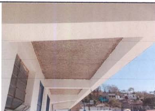
Foto 5: colocacion de lamparas led
