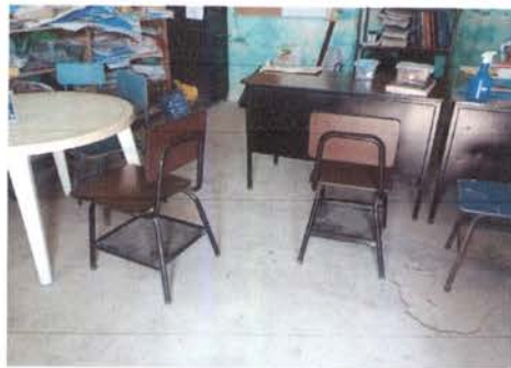
Foto 3: sustitucion de piso de torta por piso cerámico antideslizante en Dirección
