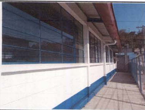
Foto 5: Colocacion de balcones y cedazo de aulas
