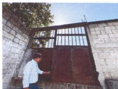
SUSTITUCIÓN DE PORTON DE METAL
