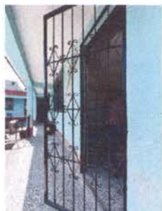
MANTENIMIENTO A ESTRUCTURA DE PUERTAS DE METAL, SUSTITUCIÓN DE CHAPAS.
