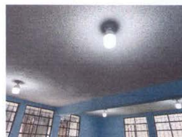
REPARACIÓN DEL SISTEMA ELECTRICO, SUSTITUCIÓN DE LÁMPARAS, PLAFONERAS, INTERRUPTORES Y TOMACORRIENTES.
