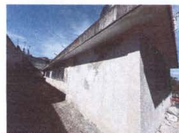
REPELLO Y ALISADO EN MUROS (PAREDES) EXTERIOIR DE ATRÁS DE LAS AULAS
