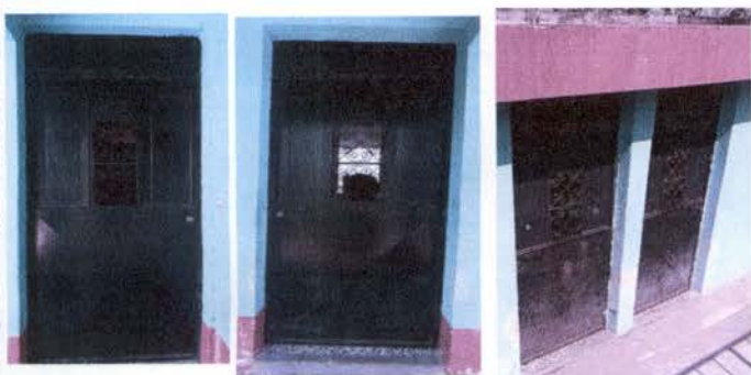
Foto1: Mantenimiento de estructura metalica,lijado cambio de tubo,sujeciones ,aplicación de pintura.
