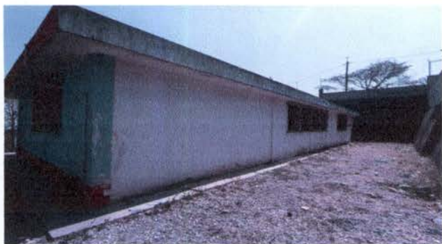
Foto 8: Repello de muros y alisado de paredes de la parte lateral del centio educativo, entrada principal
