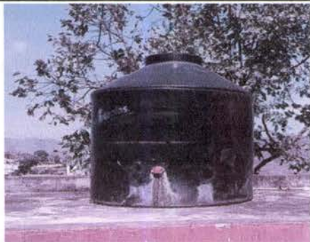
Foto7: Sustitución de depósito de agua
