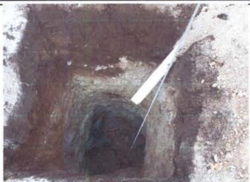
Foto 7: sustitución de fosa séptica para el funcionamiento de los servicios sanitarios.
