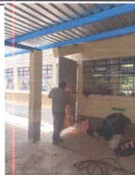
Foto 2: Mantenimiento a puertas de metal.
