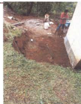
Foto 6: instalación de pila de cemento de 2 lavaderos (uso de sanitarios)
