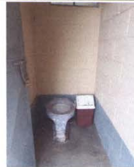
Foto 4: Sustitución de inodoros, mantenimiento a puertas y sustitución de fosa séptica para el funcionamiento de los servicios sanitarios.
