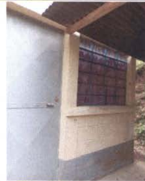
Foto 2: Mantenimiento a puertas de metal.
