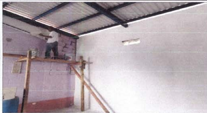
Foto1: Repello de aula de preparatoria
