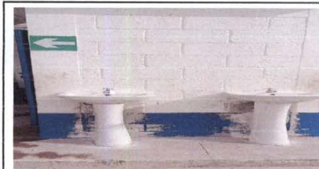
Foto 5 :Instalación de lavamanos
