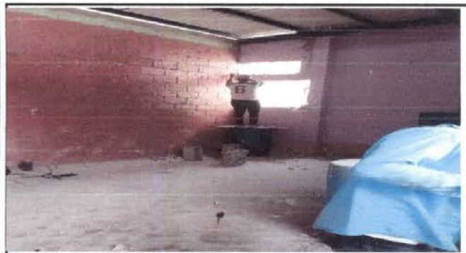
Foto 3: ampliacion de ventanas de aula de preparatoria
