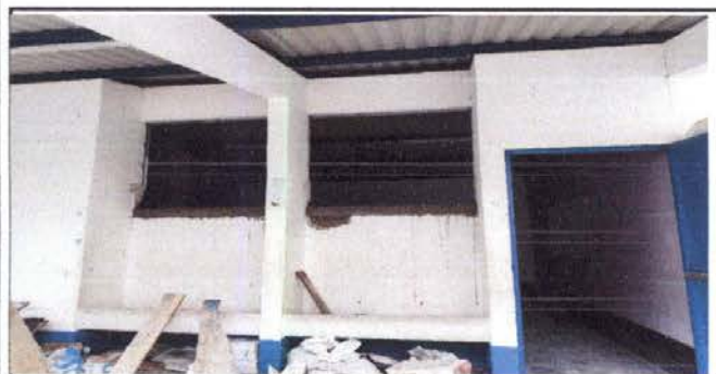
Foto 5: ampliacion de ventanas
