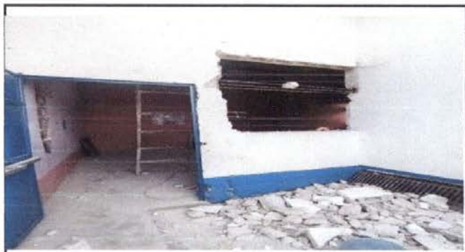
Foto 4: ampliacion de ventanas de aula de preparatoria
