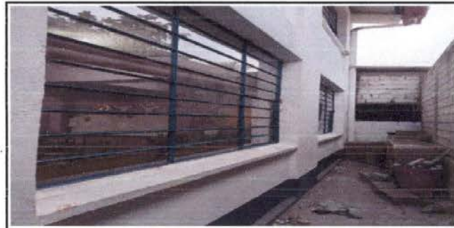
Foto 6: colocacion de ventanas y sustitucion de vidrios
