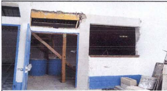
Foto 1: Repello de aula de preparatoria
