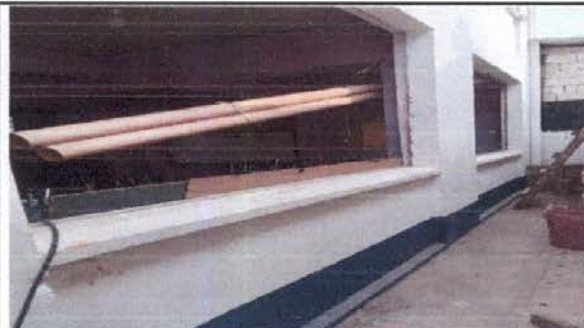
Foto 5: Desmotaje de ventanas en mal estado
