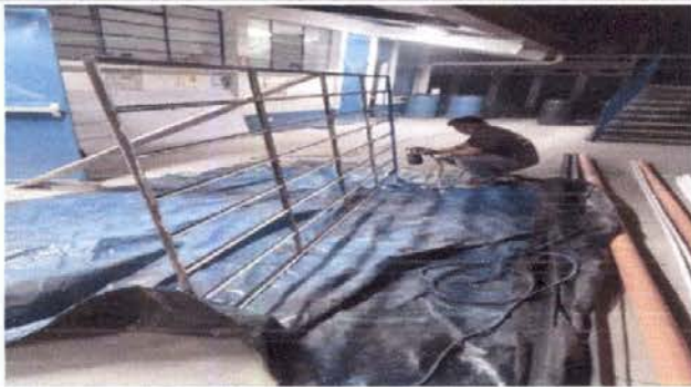
Foto1: Se debe realizar repello, sabietado y alizado para evitar filtración de agua
