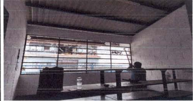
Foto 2: reparacion de ventana y sustitución de vidrios.
