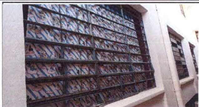
Foto 1: se trabaja mantenimiento a ventanas y sustitución de vidrios
