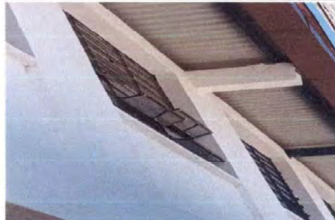
Foto 4: reparación de ventanas y sustitución de vidrios
