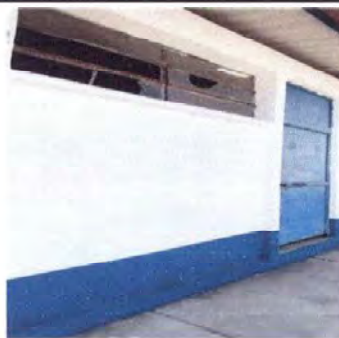
Foto 2: reparación de ventana y sustitución de vidrios.
