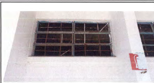
Foto 2: se realizara sustitución de ventana y colocación de vidrios
