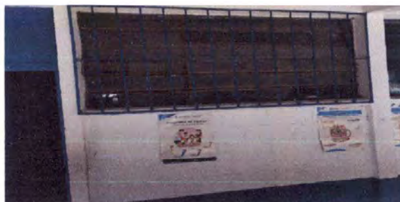
Foto 6: reparación de ventana y sustitución de vidrios
