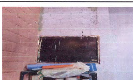
Foto 4: se trabajara fabricacion de ventana de metal
