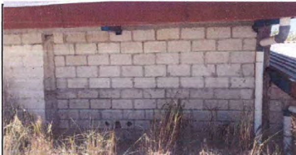
Foto 6: Parte dañada de pared de aula donde se realizara repello, sabietado y alisado para evitar filtración de agua
