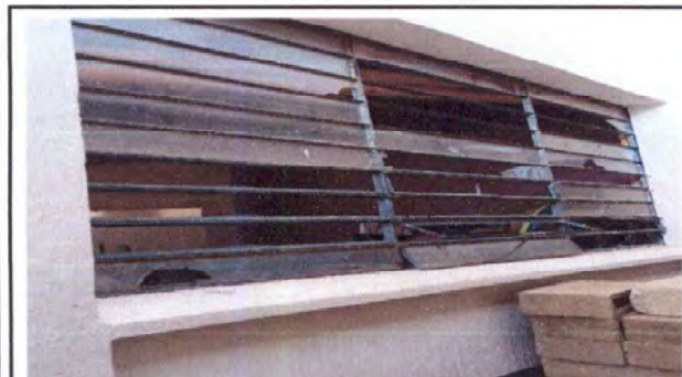
Foto 3: se trabaja sustitucion de vidrios y mantenimiento de estructura de metal de ventana
