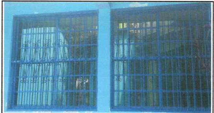
Foto 4: Lijado y pintura a balcones.
