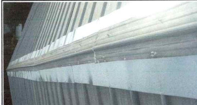
Foto 8: Instalación de 20 mts de capota a aula de preprimaria
