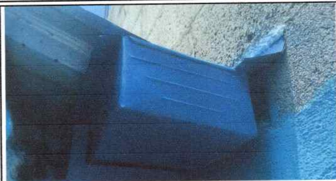
Foto 19: Reparación de canal de aguas pluviales
