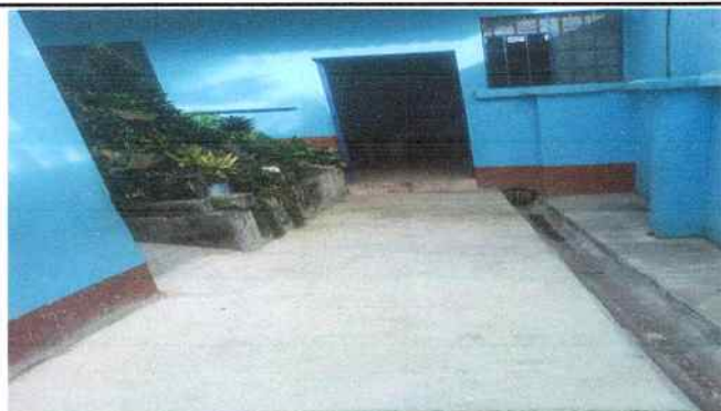
Foto 15: Construccion de banqueta en area de cocina
