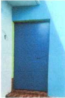
Foto1: Lijado y pintura de puertas.
