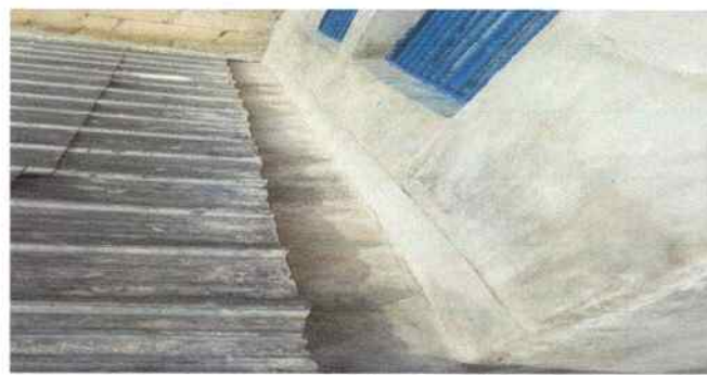
Foto 16; Construccion de 5 metros lineales de canal aereo de cemento
