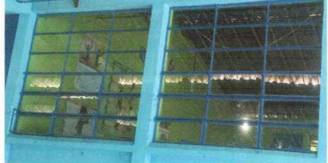
Foto 2: Lijado y pintura a ventanales.
