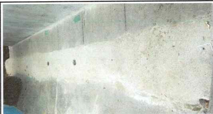
Foto 7: Construcción de banqueta (se colocó tubo de cemento de 12 pulgadas y encima de los tubos se colocó una banqueta).
