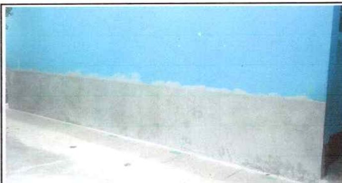
Foto 9: Quitado e instalación de cernido de entrada principal
