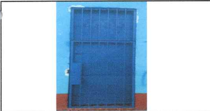
Foto 11: Fabricación e instalación de puerta de rejas.
