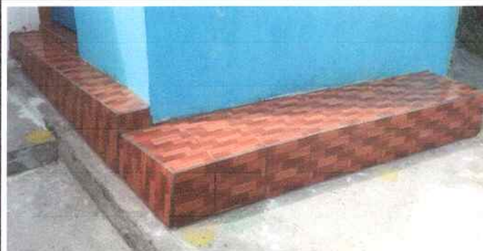
Foto No. 17; Instalación de piso ceramico a gradas de tienda escolar.
