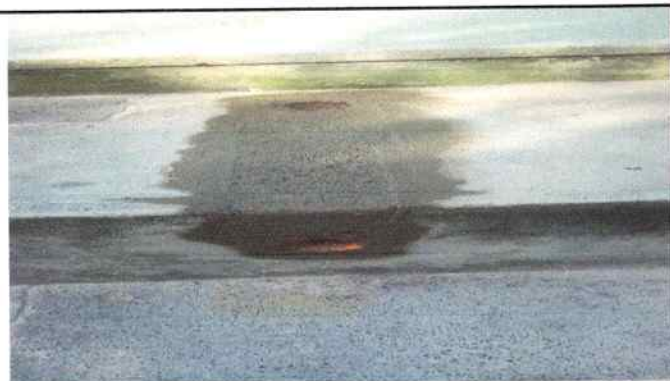
Foto 21: Instalacion de 1 metro lineal de drenaje
