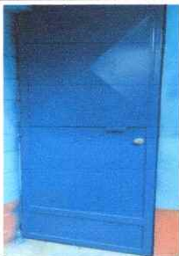
Foto13: Instalacion de chapa nueva.
