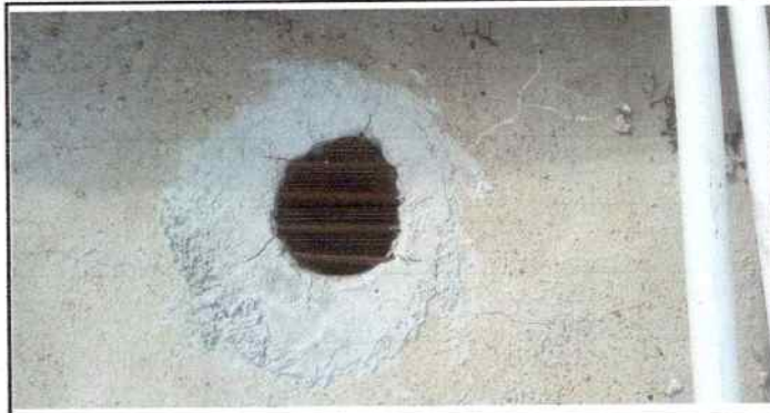
Foto 20 : Fabricación e instalación de parrilla de hierro de 3/8 a drenajes de aguas pluviales.
