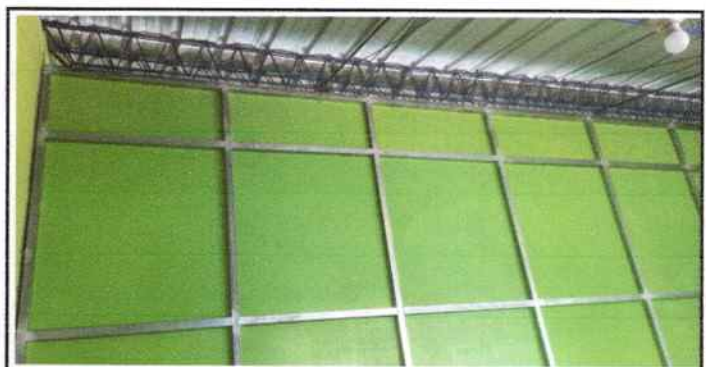
Foto 6: Sustitucion de division de madera y plywood por tubos de metal de 2 pulgadas y plywood. Aula No. 4
