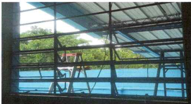
Foto 3: Sustitución de vidrios.
