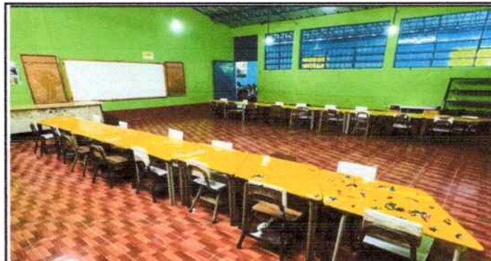
Foto 10: Instalación de piso cerámico a aula de preprimaria.
