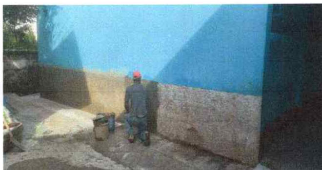
Foto 15: Quitado e instalacion de cernido de entrada principal
