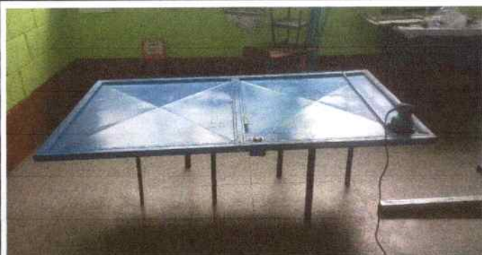
Foto1: Lijado y pintura de puertas.
