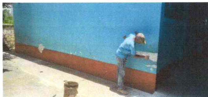
Foto 14: Quitado e instalacion de cernido de entrada principal
