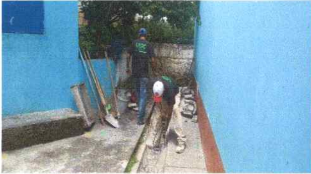
Foto 7: Construcción de banqueta ( se colocara tubo de cemento de 12 pulgadas y encima de los tubos se colocara una banqueta.
