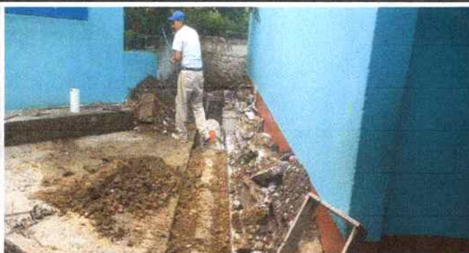
Foto 9: Construcción de banqueta ( se colocara tubo de cemento de 12 pulgadas y encima de los tubos se colocara una banqueta.
