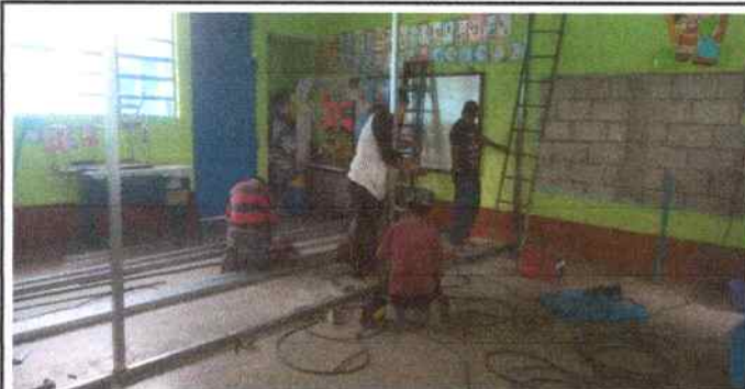
Foto 6: Sustitucion de division de madera y plywood por tubos de metal de 2 pulgadas y plywood. Aula No. 7
