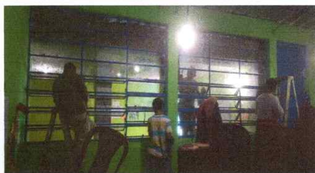
Foto 2: Lijado y pintura a ventanales.
