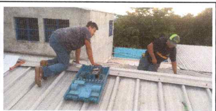
Foto 12: Instalación de 20 mts de capota a aula de preprimaria
