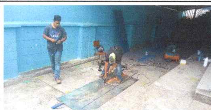
Foto 11: Instalación de 20 mts de capota a aula de preprimaria
