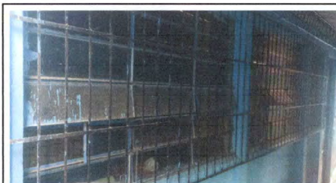
Foto 4: Lijado y pintura a balcones.
