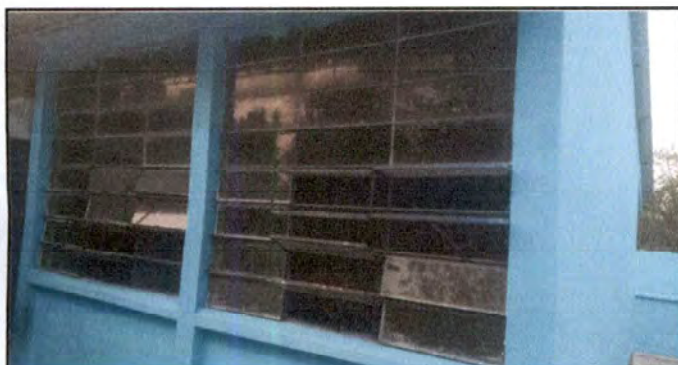
Foto 3: Sustitución de vidrios. (los vidrios estan manchados no se han cambiado desde la creacion de la escuela año 1998. Solo se cambiarian algunos por que no alcanza el presupuesto)
