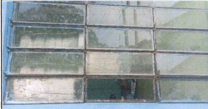
Foto 2: Lijado y pintura a ventanales.
