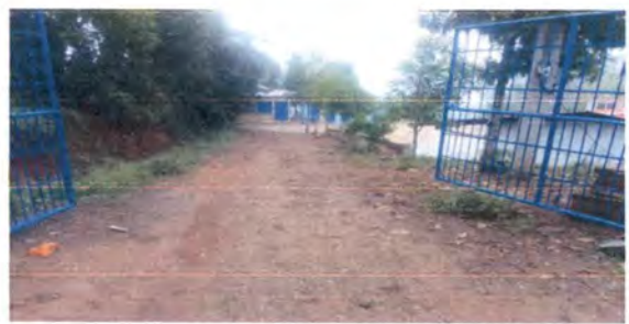
Foto 2: Suministro y fundición de losa de concreto en ingreso a establecimiento
