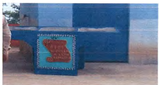
Foto 4: Instalación de pila de 2 lavaderos
