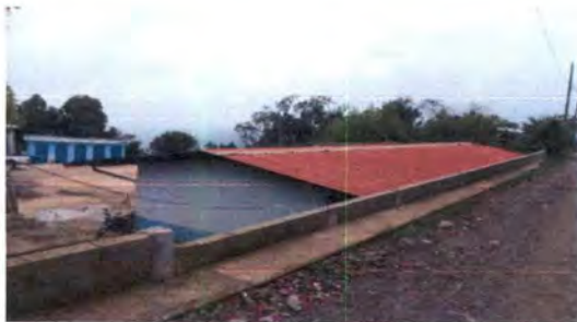
Foto 1: Reparación de muro perimetral de block incluye instalación de malla galvanizada con tubo HG
