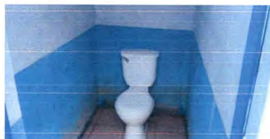
Foto 6: Suministro e instalación de azulejo en baños
