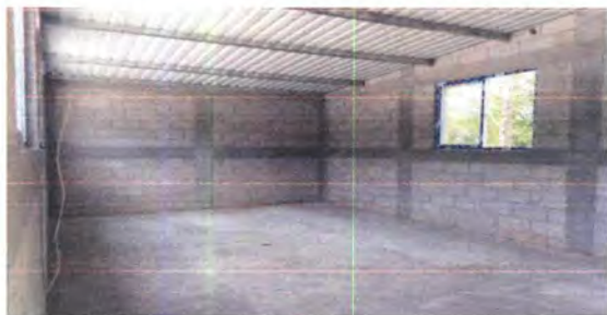
Foto1: Suministro e instalación de piso cerámico en aula
