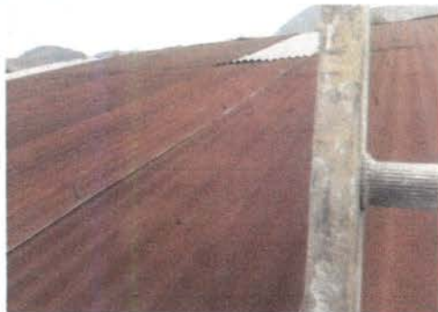
Foto 1: sustitución de lámina por lámina troquelada aluzinc calibre 26 prepintada R/B en 1 aula virtual
