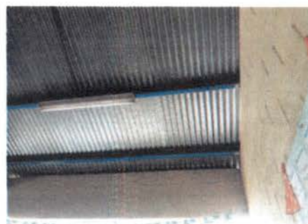
Foto 2: Pintura de techo exterior de 6 aulas, dirección y biblioteca, cocina. Incluye sellado de tornillos, limpieza y pintura de estructura metálica.
