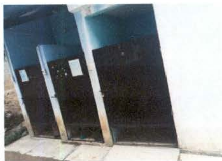
Foto 5: Lijado, pintura y reparación de parte inferior de de las 6 puertas del sanitario.
