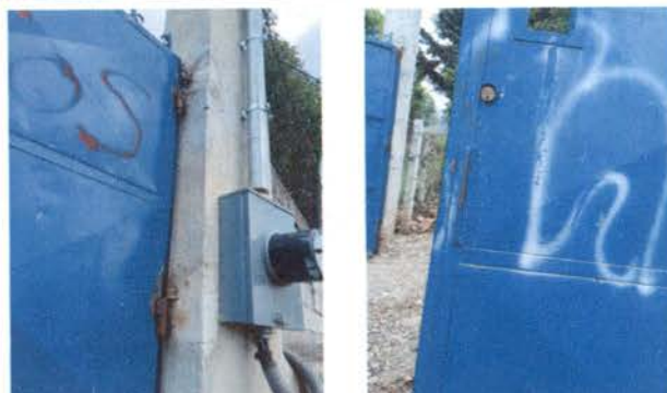
Foto 4: Mantenimiento de portón principal, incluye apertura de puerta peatonal integrada al portón, sustitución de marco, chapa y visagras, lijado y pintura.
