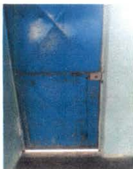
Foto 5: Mantenimiento de puertas, incluye lijado y pintura de 7 puertas de metal.
