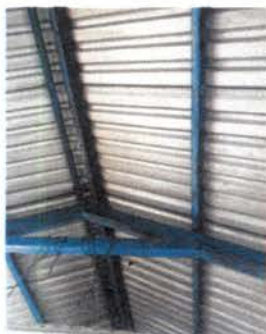
Foto 3: Pintura de techo exterior de 6 aulas, dirección y biblioteca, cocina. Incluye sellado de tornillos, limpieza y pintura de estructura metálica.
