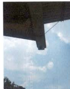
Foto 2: Complementación y mantenimiento de canales de agua pluvial, incluye soportes metálicos y bajadas de agua con tubos pvc de 4 pulgadas.
