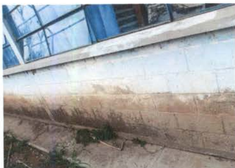
Foto 3: Pintura exterior e interior de paredes de toda la escuela
