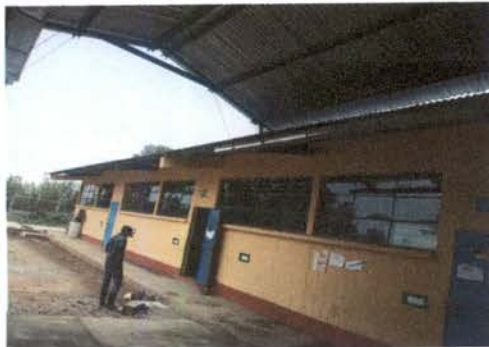
Foto 1: Complementación y mantenimiento de canales de agua pluvial, incluye soportes metálicos y bajadas de agua con tubos pvc de 4 pulgadas.
