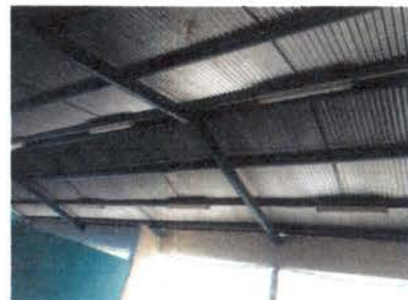
Foto 4: Pintura de techo exterior de 6 aulas, dirección y biblioteca, cocina. Incluye sellado de tornillos, limpieza y pintura de estructura metálica.
