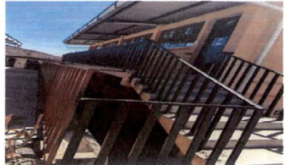
Reparación y mantenimiento de barandales
