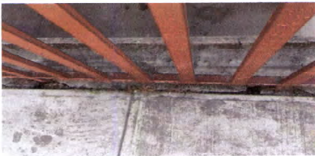
Mantenimiento a barandales
