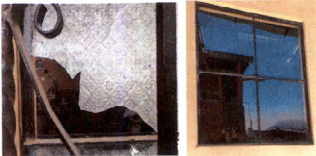
Cambio de vidrios e instalación de balcones
