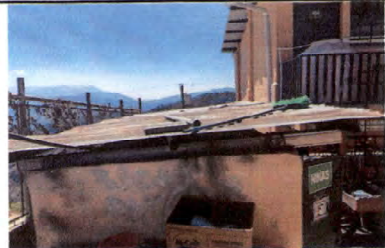
Sustitución de lámina por lámina troquelada calibre 26 alucinc en área de sanitarios
