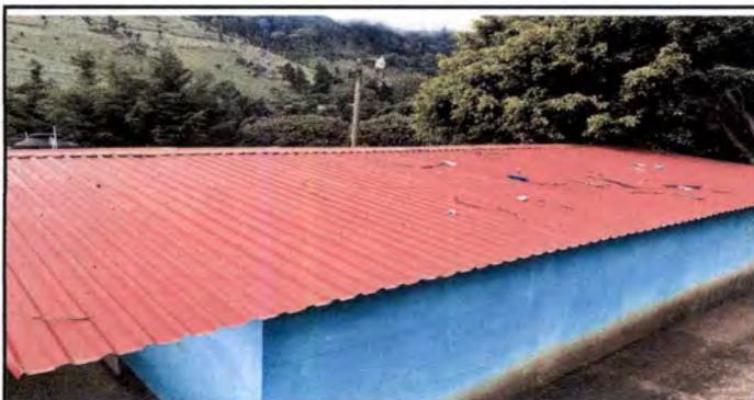
Foto 3: Canales y Bajadas de Agua
