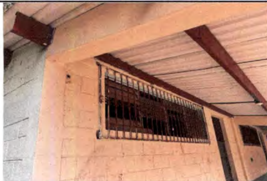
Foto1: Pintura de Muros Exteriores e Interiores
