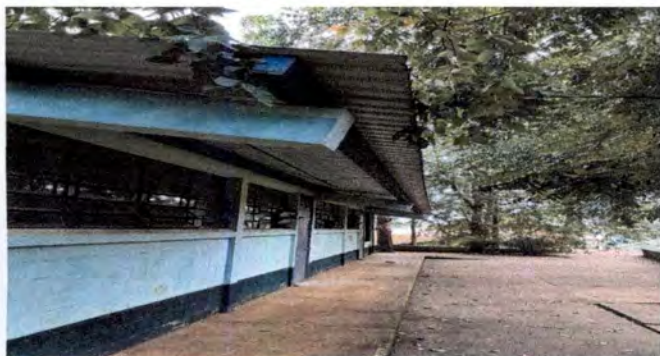
Foto1: Canales y Bajadas de Agua
