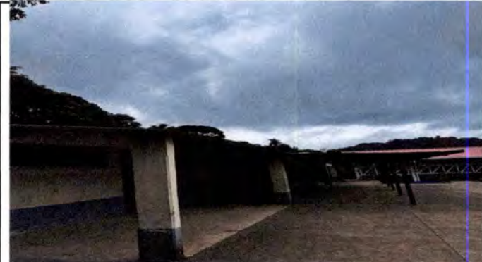
Foto 2: Pintura de Muros Exteriores e Interiores
