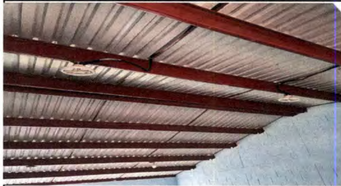
Foto 4: Reparación del Sistema Eléctrico
