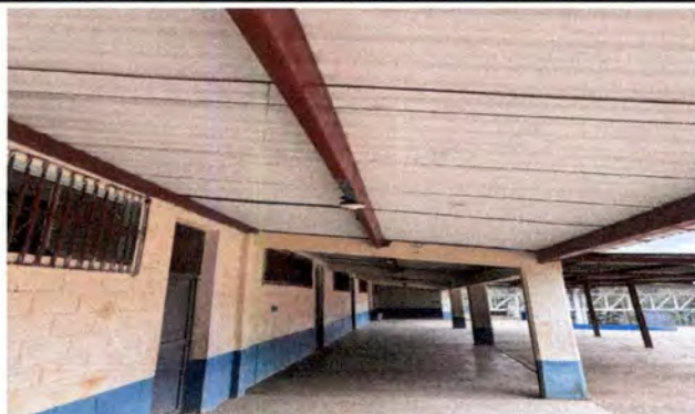
Foto 3: Reparación del Sistema Eléctrico
