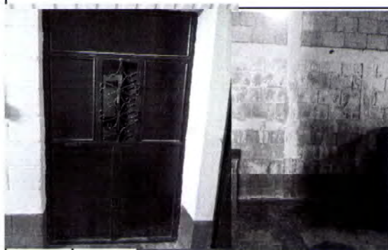
Foto 3: Pintura en paredes del interior de aulas
