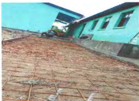
Foto 43: Fundición de planchas de concreto (losa de patio)
