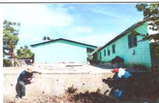
Foto 51: Fundición de planchas de concreto (losa de patio) y tallado de muro.
