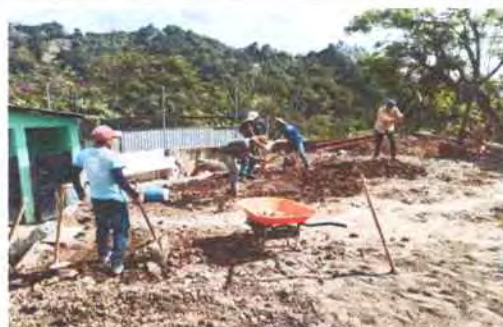
Foto 36: Preparación del suelo para nivelar la tierra.
