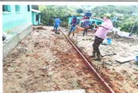
Foto 42: Colocación de electromalla para reforzar las planchas de concreto
