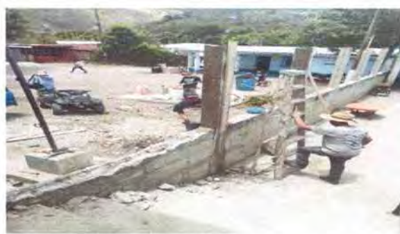
Foto 10: Muro perimetral: donde se tiene previsto la Sustitución de balcones de metal, pintura interior y exterior. Se está arreglando la base del muro donde van a colocarse los balcones y se está realizando cernido a la parte de columnas y base.
