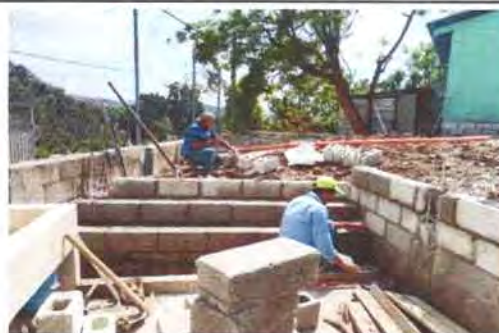
Foto 30: Construcción de gradas para llegar al nivel de la losa de patio.
