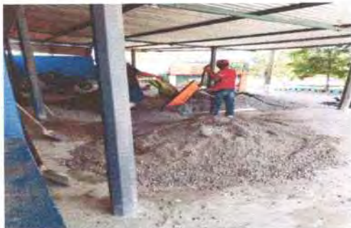
Foto 49: Preparación de material para fundir planchas de concreto (losa de patio)
