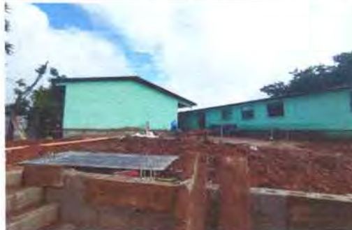
Foto 40: Preparación del suelo para colocar las electromallas para reforzar las planchas de concreto.
