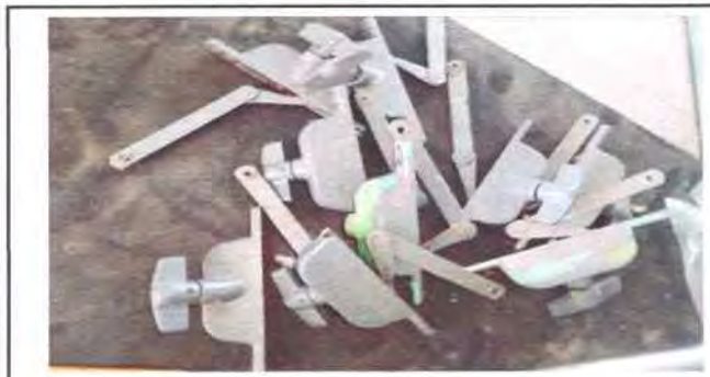
Foto 3: Operadores que fueron quitados de las ventanas de las aulas de segundo y tercero primaria, se tiene previsto hacer mantenimiento a marcos de aluminio mill finish y se colocaran vidrio(paletas).
