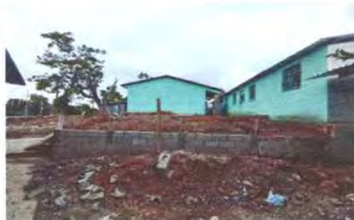
Foto 24: Preparación del suelo para losa de patio en área recreativa.
