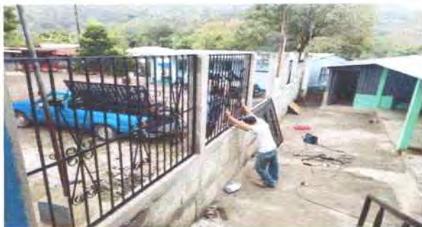
Foto 15: Muro perimetral: colocación de balcones de metal.
