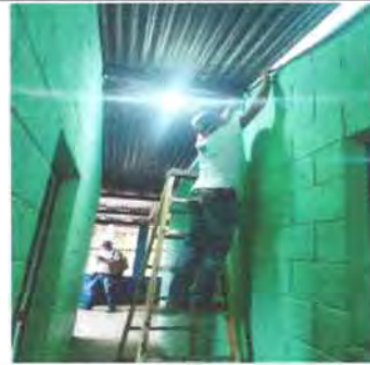
Foto 60: Sustitución de focos ahorradores aulas de párvulos, segundo, tercero, cuarto y corredores.
