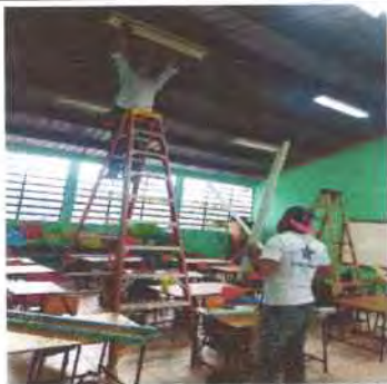
Foto 55: Reparación e instalación de lámparas de dos tubos cada una en aula de primero primaria.
