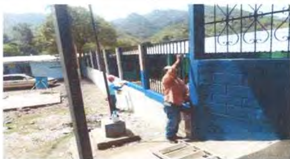
Foto 17: Muro perimetral: pintura exterior
