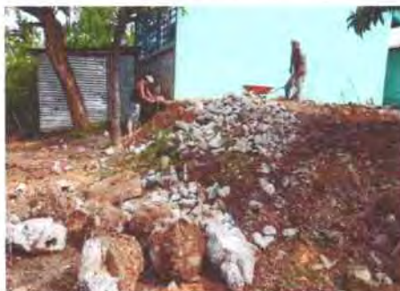
Foto 26: Preparación del suelo y construcción de muro para nivelar la tierra.
