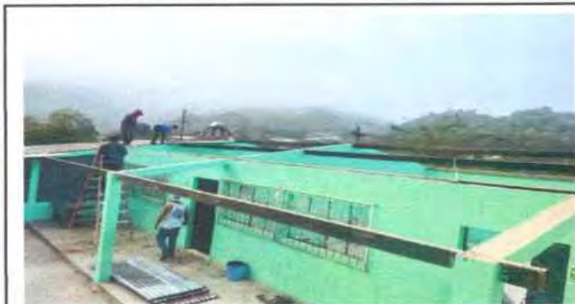
Foto 1: Desinstalación de lámina de en las aulas de Segundo y tercero primaria donde se realizará la sustitución de lámina por lámina troquelada aluzin calibre 26 y mantenimiento de techo.
