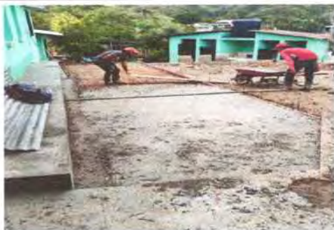
Foto 45: Fundición de planchas de concreto (losa de patio)
