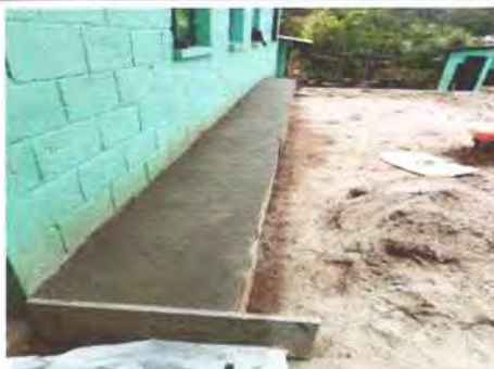
Foto 39: construcción de banca para reforzar la pared del aula de párvulos y para que se sienten los alumnos.
