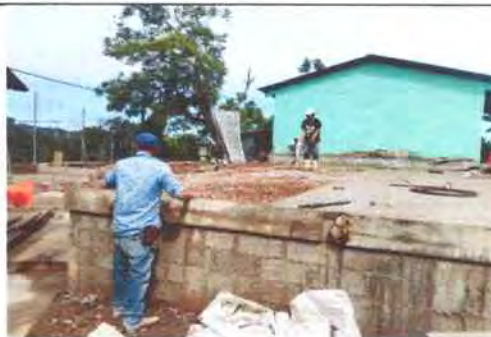
Foto 48: Fundición de planchas de concreto (losa de patio)
