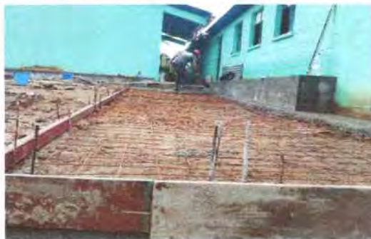
Foto 44: Fundición de planchas de concreto (losa de patio)
