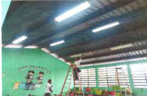
Foto 56: Reparación e instalación de lámparas de dos tubos cada una en aula de primero primaria.
