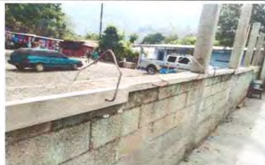
Foto 12: Muro perimetral: donde se tiene previsto la Sustitución de balcones de metal, pintura interior y exterior. Se está arreglando la base del muro donde van a colocarse los balcones y se está realizando cernido a la parte de columnas y base.
