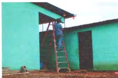
Foto 32: Instalación de pescantes para luego colocar los canales metálicos y bajadas de pvc.
