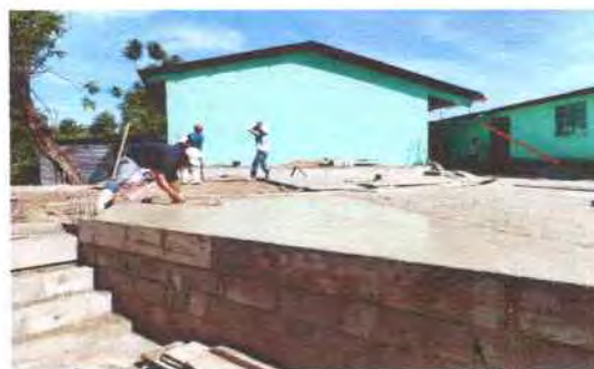
Foto 50: Fundición de planchas de concreto (losa de patio)
