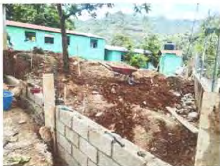
Foto 27: Preparación del suelo y construcción de muro para nivelar la tierra.
