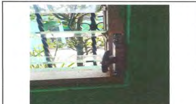
Foto 4: Cambio de operador en ventanas de las aulas de segundo y tercero primaria. Mantenimiento a marcos de aluminio mill finish y se colocaran vidrio(paletas).
