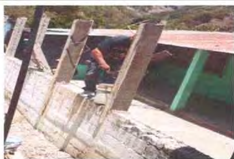
Foto 11: Muro perimetral: donde se tiene previsto la Sustitución de balcones de metal, pintura interior y exterior. Se está arreglando la base del muro donde van a colocarse los balcones y se está realizando cernido a la parte de columnas y base.
