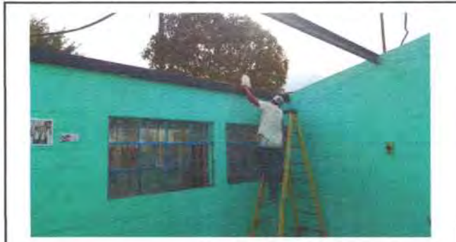
Foto 2: Mantenimiento a estructura de soporte de metal ) limpiado, lijado, pintado, sustitución de secciones de costanera) módulo de las aulas de Segundo y tercero primaria.
