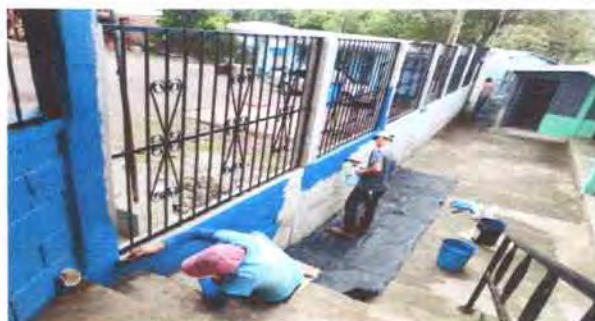
Foto 16: Muro perimetral: pintura interior.
