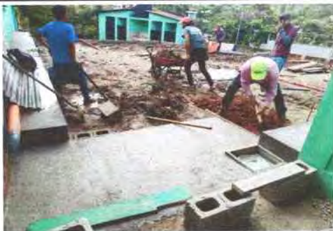
Foto 37: Preparación de suelo para fundir planchas de concreto
