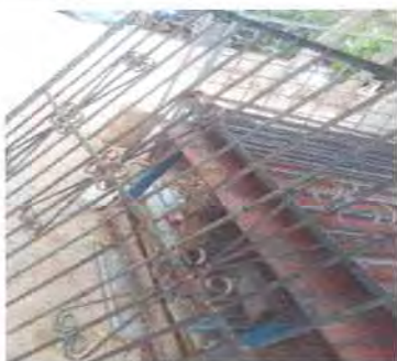
Foto 13: Elaboración de balcones para colocar en muro perimetral.
