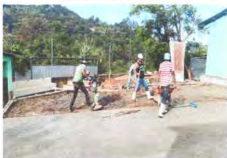
Foto 47: Fundición de planchas de concreto (losa de patio)
