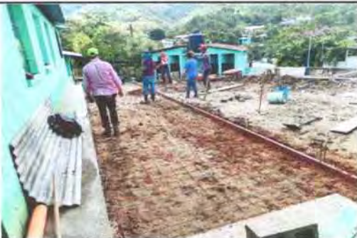
Foto 41: Colocación de electromalla para reforzar las planchas de concreto.
